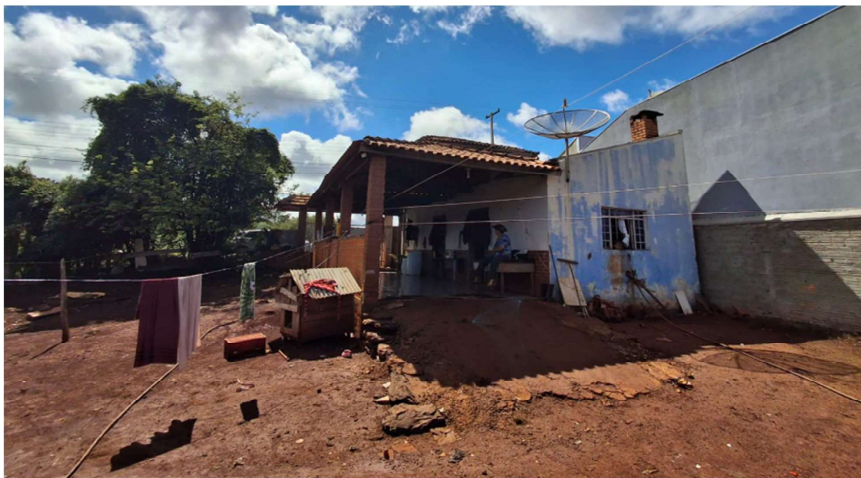
Fotografia da construção de alvenaria (fundos)
