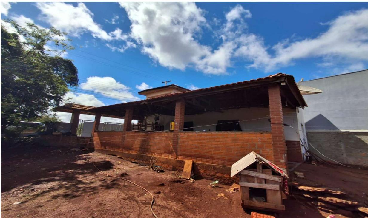
Fotografia da construção da alvenaria (lateral).
