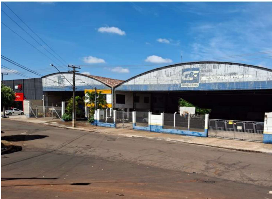
VISTA DA DIREITA PARA ESQUERDA OLHANDO DA RUA SOROCABA – OS 50 METROS TERMINAM NO FINAL DO PORTÃO E A COBERTURA METÁLICA ULTRAPASSA, POREM A AVALIAÇÃO CONTEMPLA APENAS A PARTE EXISTENTE DENTRO DOS LOTES PENHORADOS.
