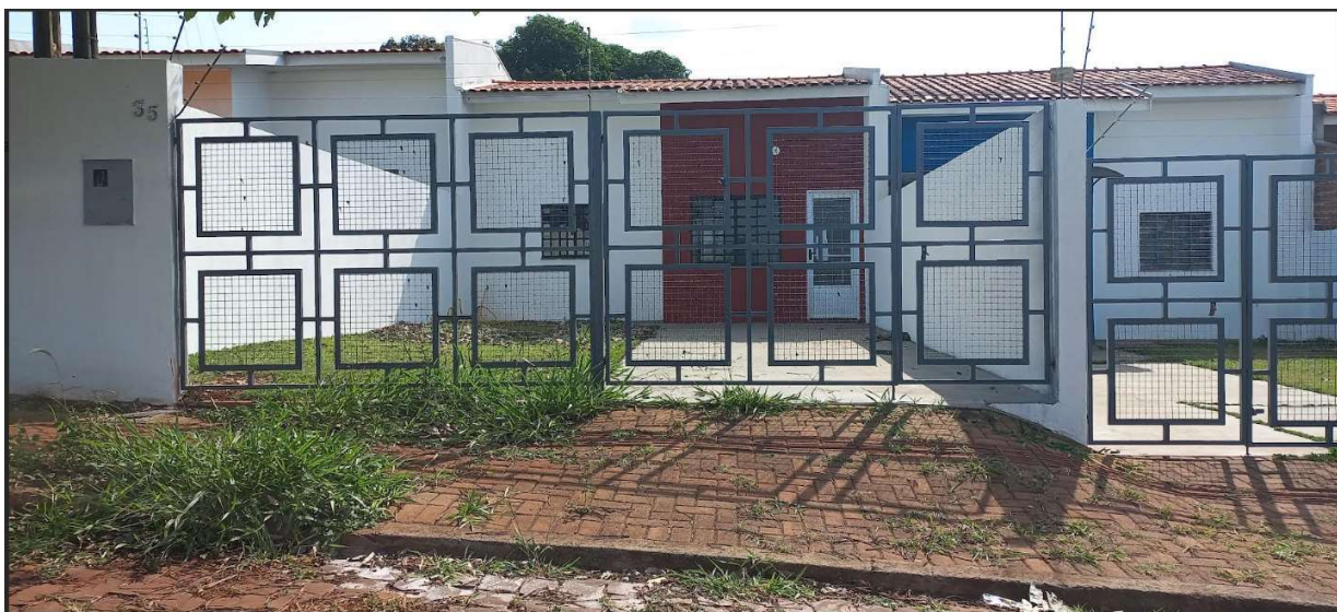
Figura 1: Fachada do imóvel
