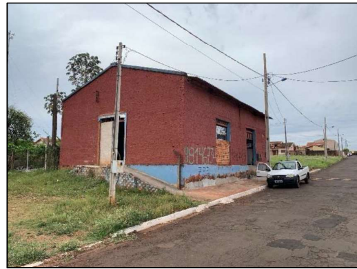
Foto 2 – Barracão na área de 5.140,95m 2
