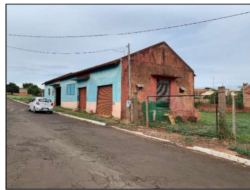
Foto 4 – Barracão na área de 4.099,45 m 2
