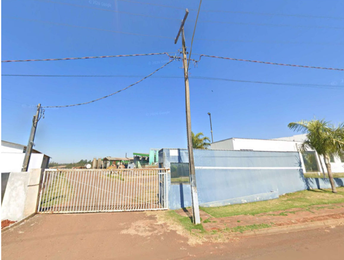
Figura 1: Fachada do imóvel. Portão.
