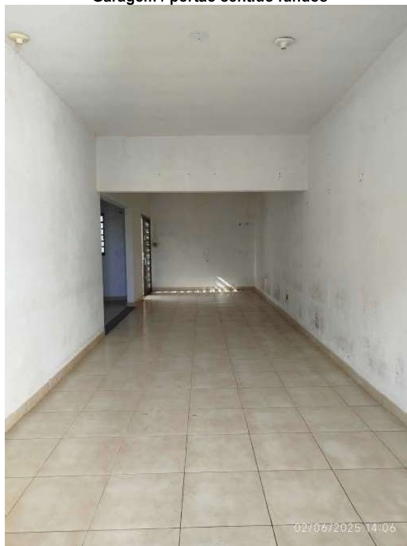
Garagem / portão sentido fundos
