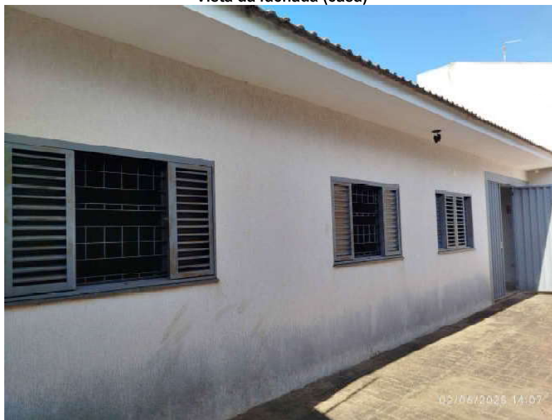
Vista da fachada (casa)
