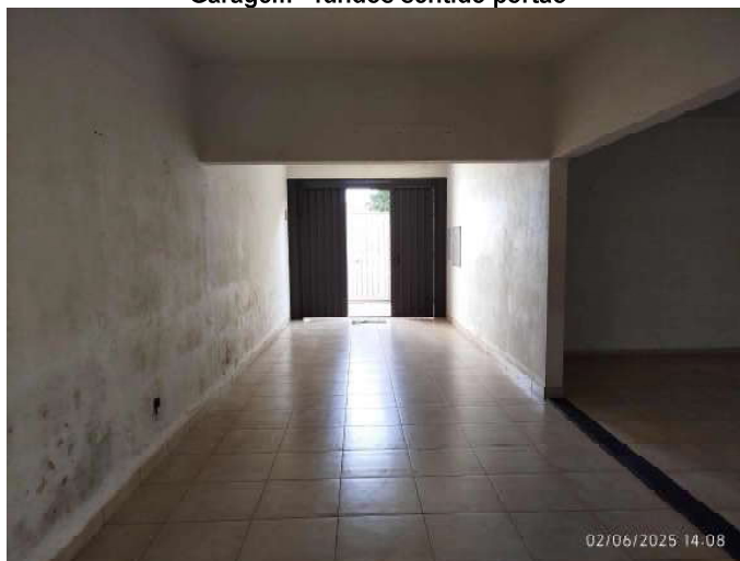
Garagem - fundos sentido portão
