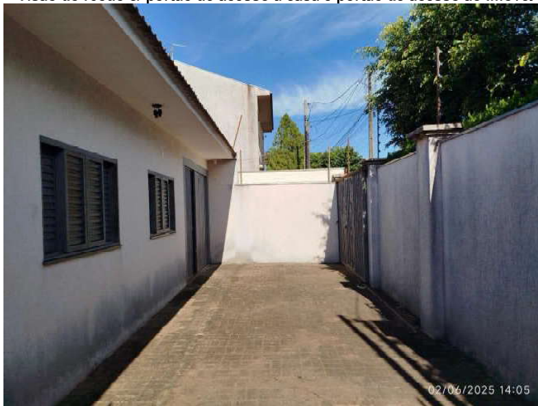
Visão do recuo c/ portão de acesso a casa e portão de acesso ao imóvel
