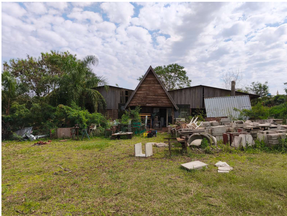
Vista externa do Depósito (05) descrito no auto de avaliação
