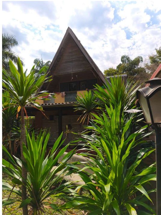
Vista dos fundos do Chalé (02) descrito no auto de avaliação
