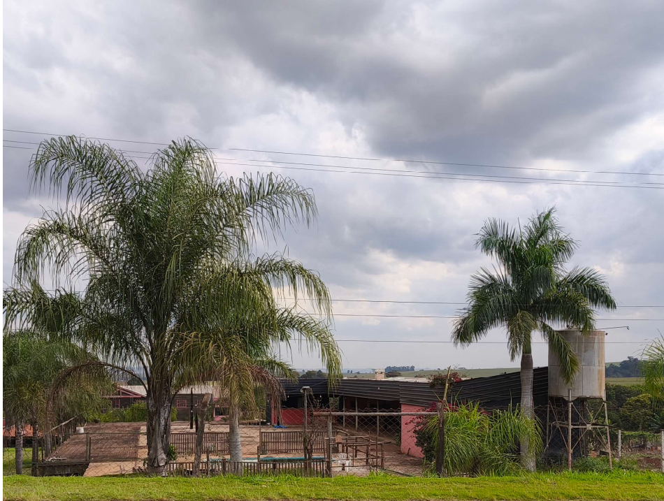
Vista frontal da Estrutura (07) descrita no auto de avaliação
