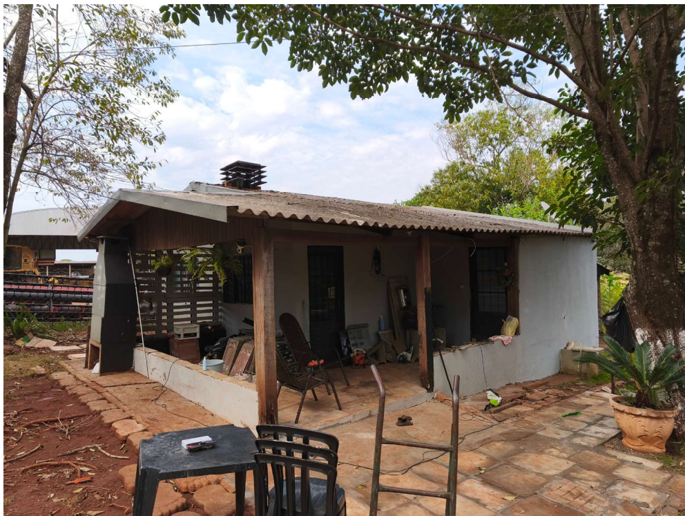
Vista da varanda da edificação residencial (03) descrita no auto de avaliação
