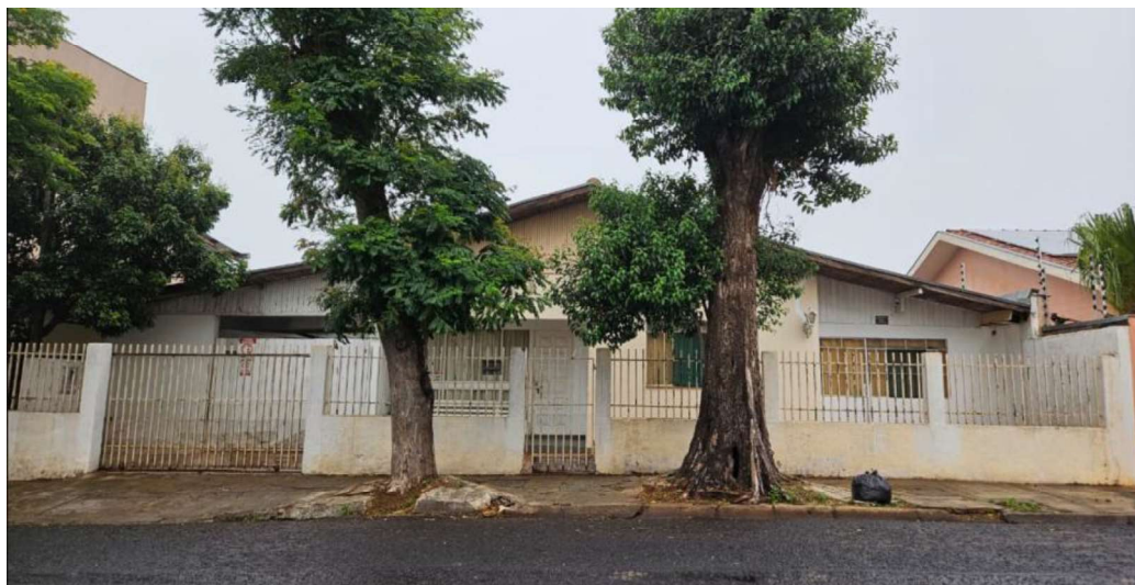
Figura 2: Fachada do imóvel. Fonte: autoral.
