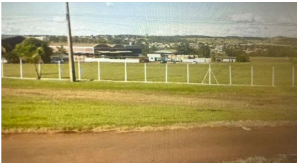
Fachada do imóvel BR 369
