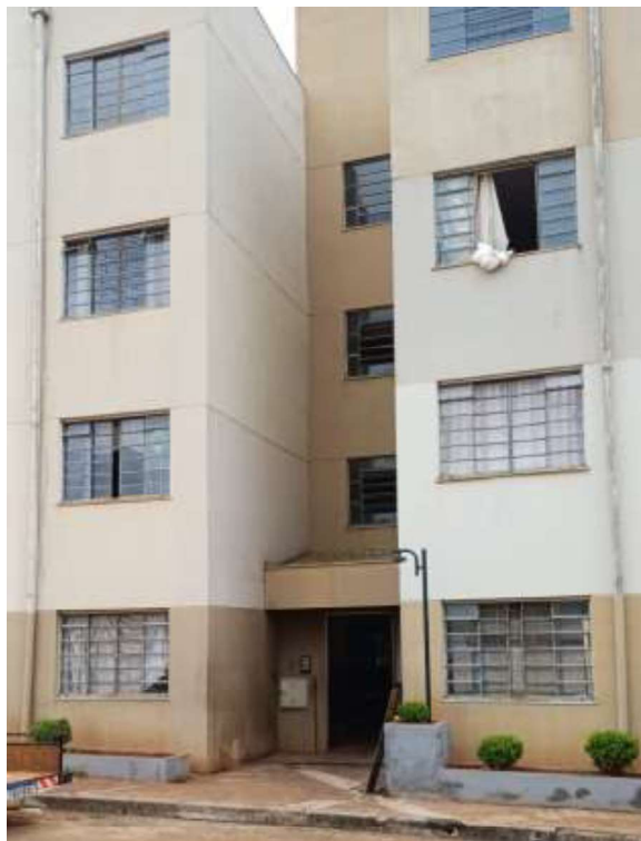
Vista frontal BLOCO 9 – RESIDENCIAL VISTA BELA, do Imóvel Avaliando – Foto – Vistoria em 11/03/2026 as 14:30h
