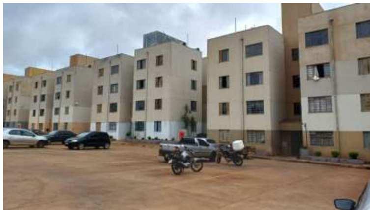
Vista frente do Condomínio Vista bela X, do imóvel avaliando – Testada Avenida Giocondo Maturi
