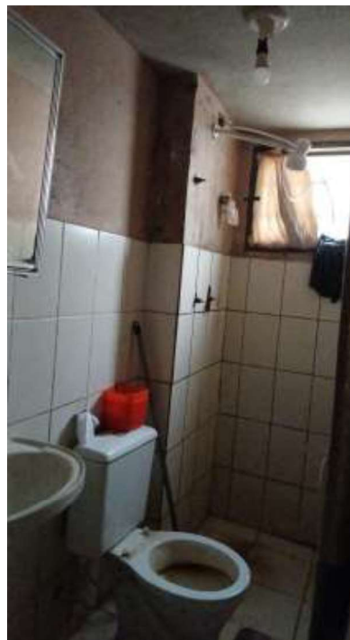
Foto: Banheiro (IA)
