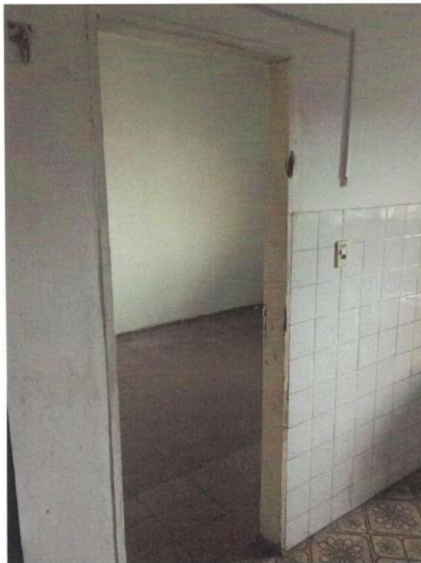
Foto 4 – Sala reservada do pavimento inferior.
