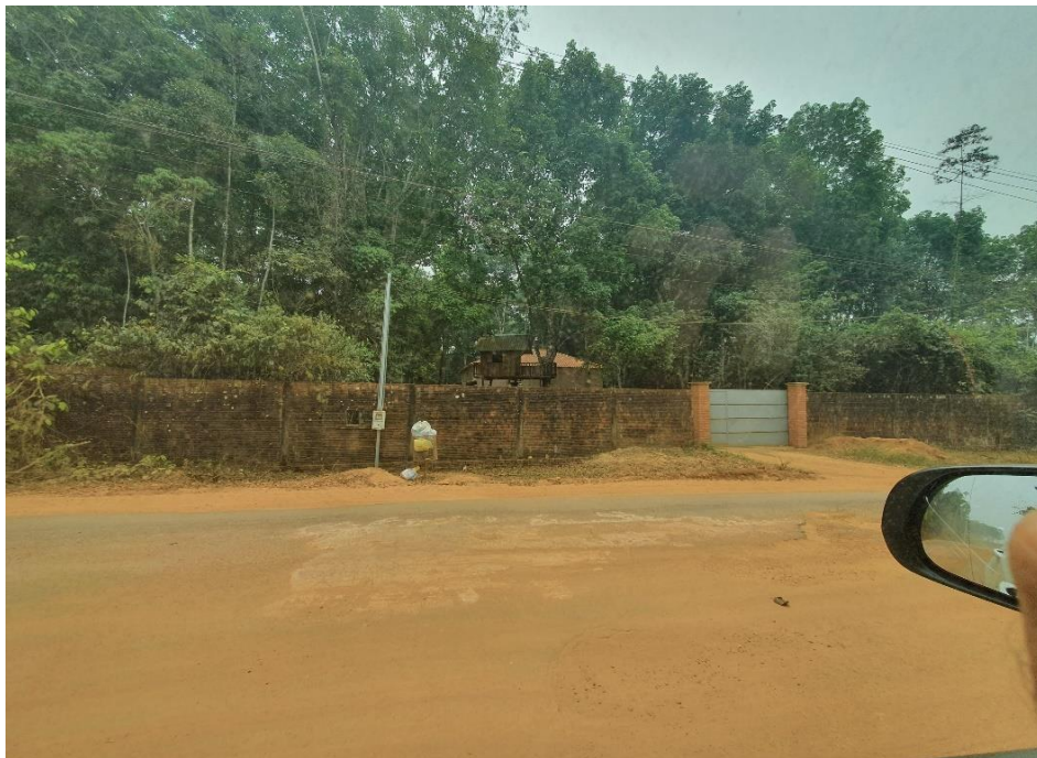
Figura 1 - Parte do Muro. Portão de entrada1
