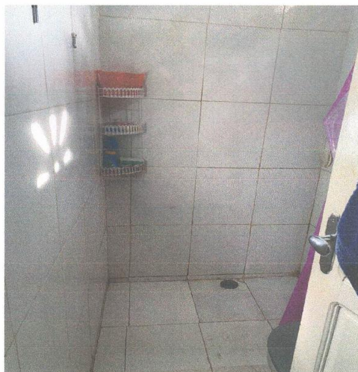
Foto 26 – Vista Banheiro Suite 02
