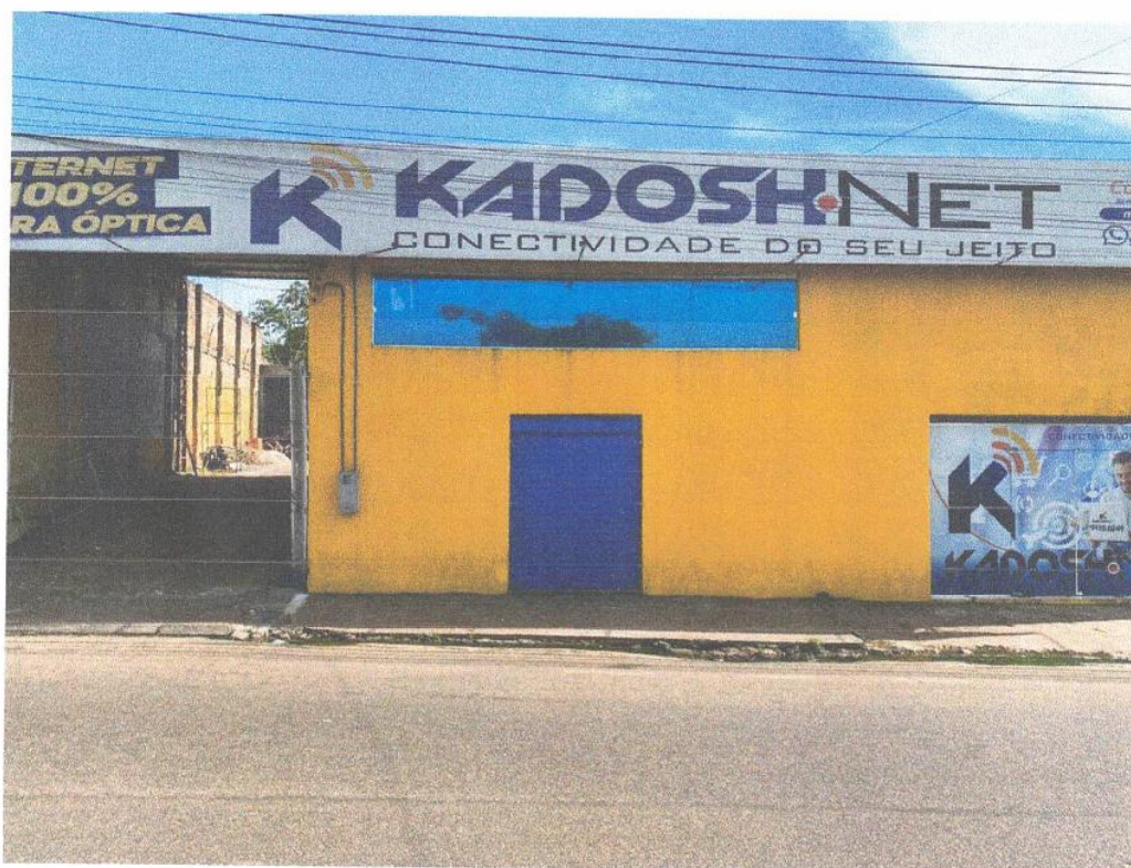
Foto 01: Vista do Imóvel Avaliando
