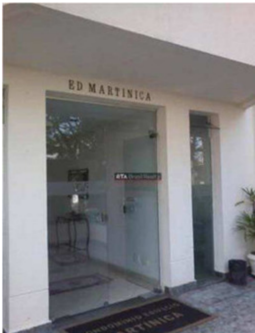
Vista Frontal do Edifício
