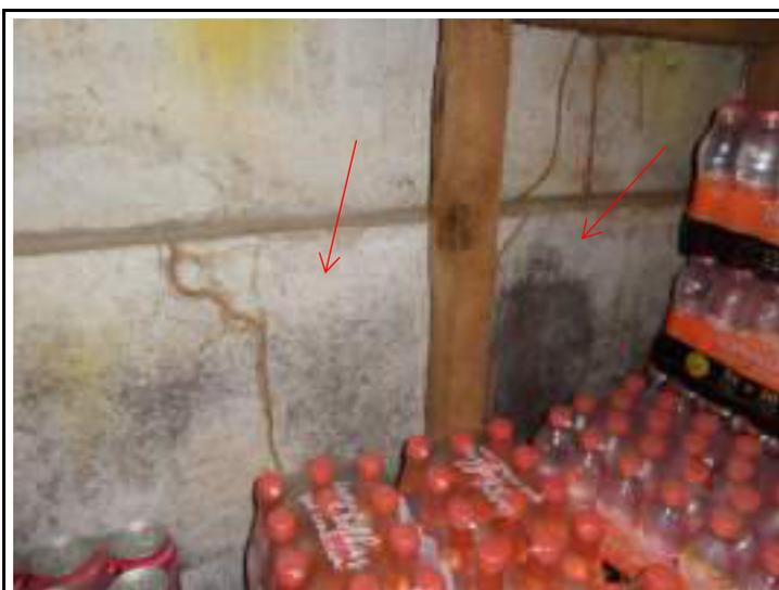
Foto 62 - Vista de mancha de umidade na parede.
