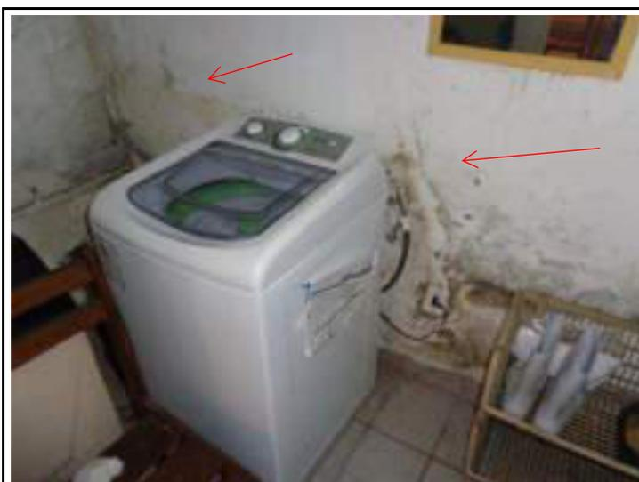
**Foto 53** - Vista de mancha de umidade na parede.
