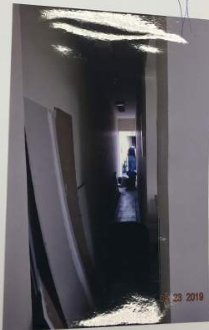
VISTA DO CORREDOR LATERAL
