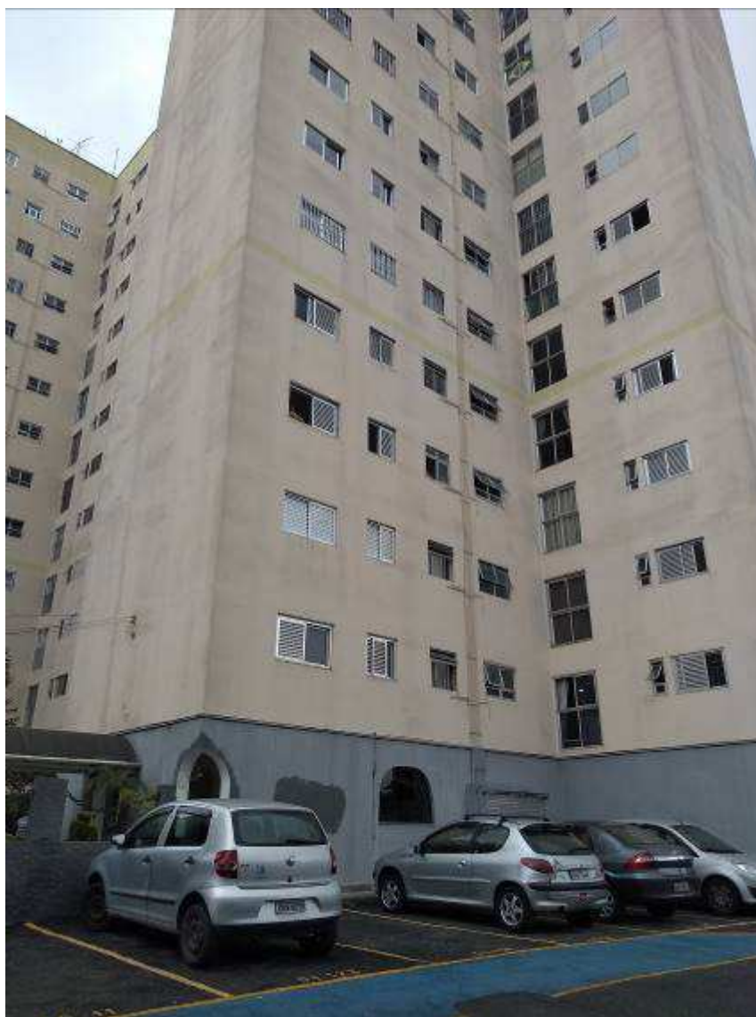
FOTO 5: FACHADA DO EDIFÍCIO.
