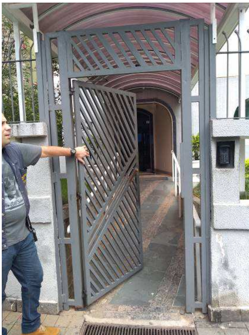
FOTO 8: ENTRADA DO EDIFÍCIO.
