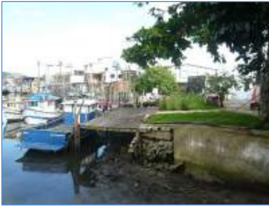
Foto 19 – Vista do canal “Rio do meio”
