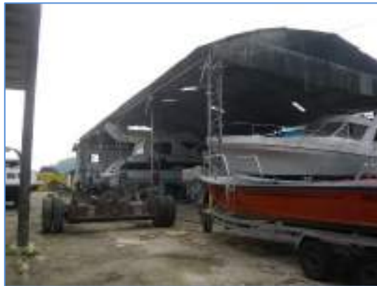
Foto 15 – Vista do Galpão 2
