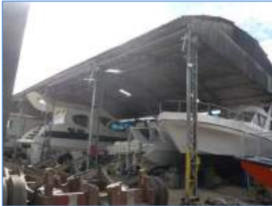
Foto 7 – Vista do galpão 2
