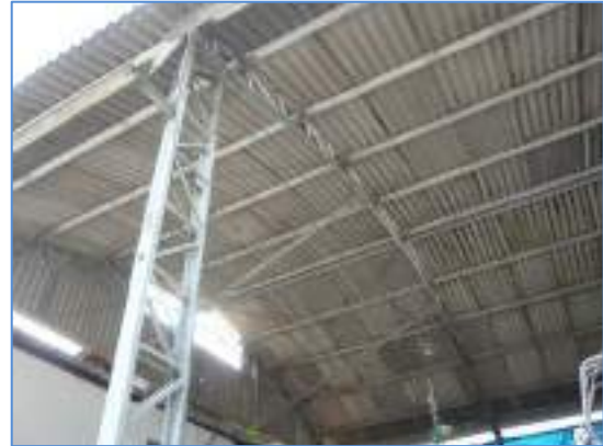
Foto 8 – Vista do galpão 2 de estrutura metálica
