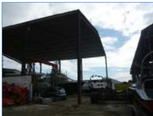
Foto 17 – Vista do galpão 1
