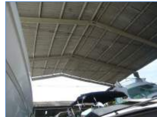
Foto 18 – Vista do galpão 1
