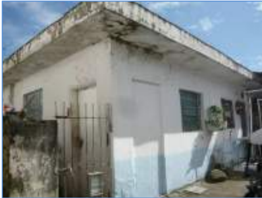
Foto 13 – Vista da edificação do lote 06
