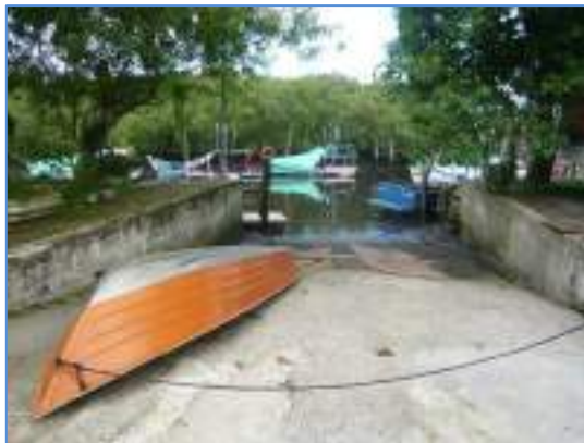
Foto 21 – Vista da rampa náutica
