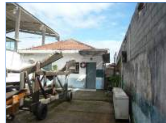
Foto 12 – Vista da edificação do Lote 06
