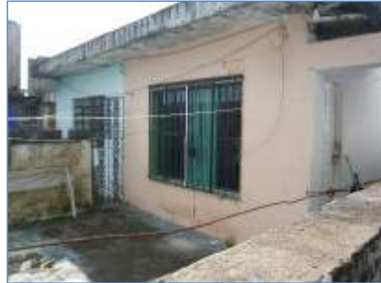
Foto 14 – Vista da edificação do lote 06
