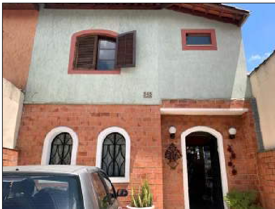
Foto 01. Fachada do imóvel avaliando.
