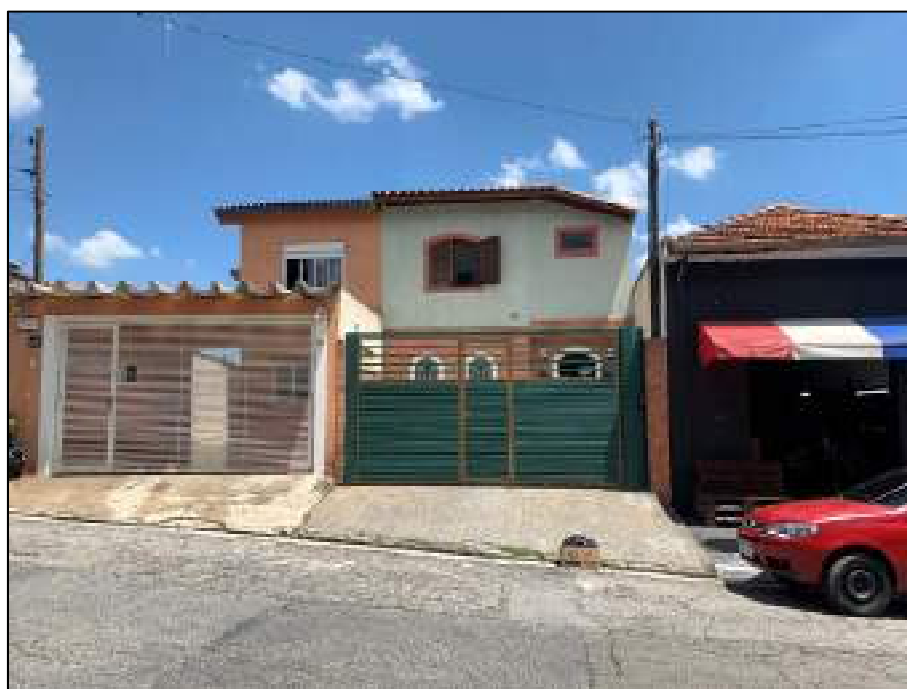
Foto 02. Vista da rua do imóvel avaliando.
