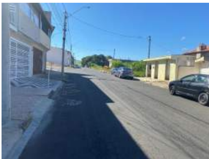
Fotos N.02 e 03 – Rua Lázaro Gonçalves Lopes – Jardim Silvestre – IV, Amparo – SP. Asfaltada, Guias e Sarjetas, Iluminação Pública, Água, Esgoto e Telefonia.
