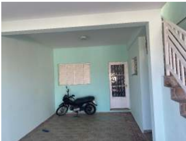
Foto N. 07 - Pavimento Térreo – Vista da Garagem para 01 Auto, Entrada do Quarto de Despejo e Janela do WC.
