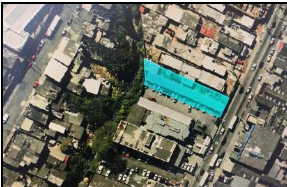
Figura 8: Vista aérea do imóvel
