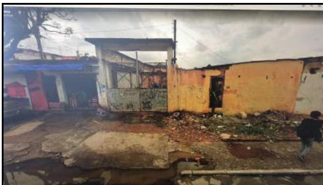
Foto 1: Rua Harry Dannenberg, n° 106 ou 148 - GOOGLE 2019
