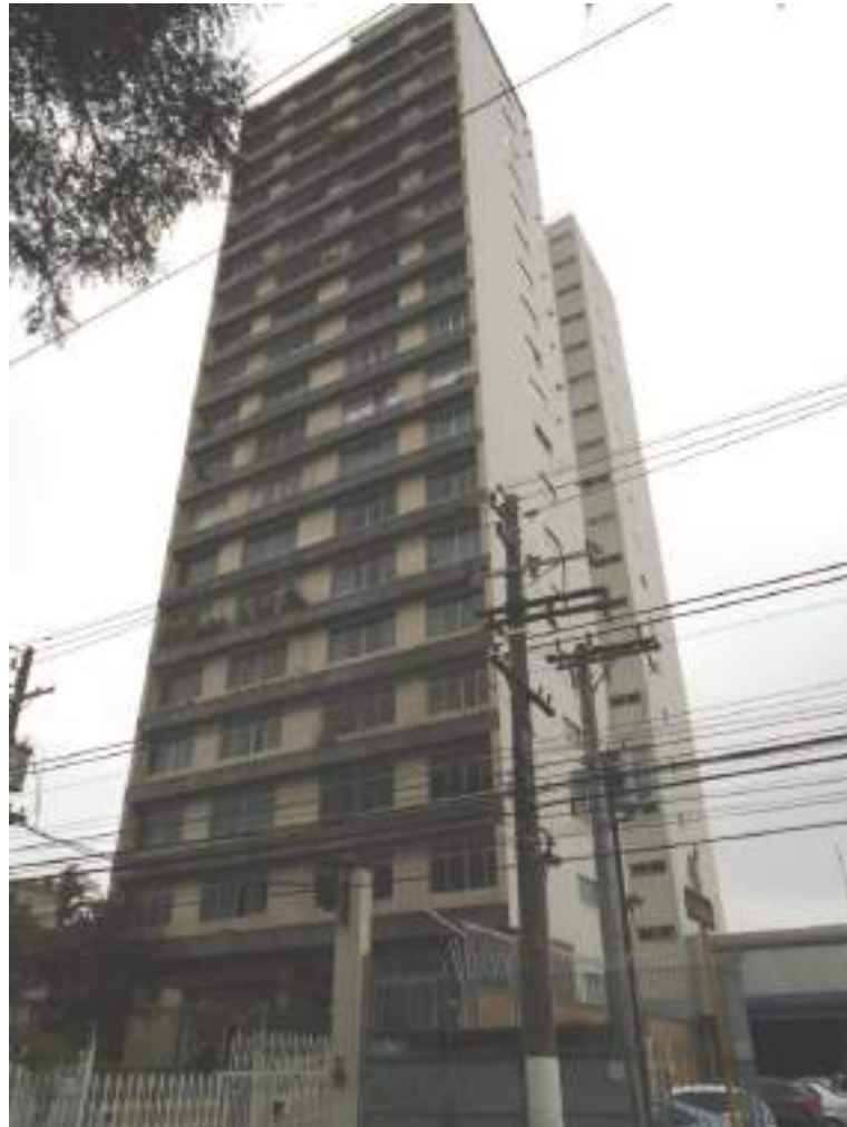
Foto nº. 3 – Vista da fachada do Condomínio Edifício Tulipas.
