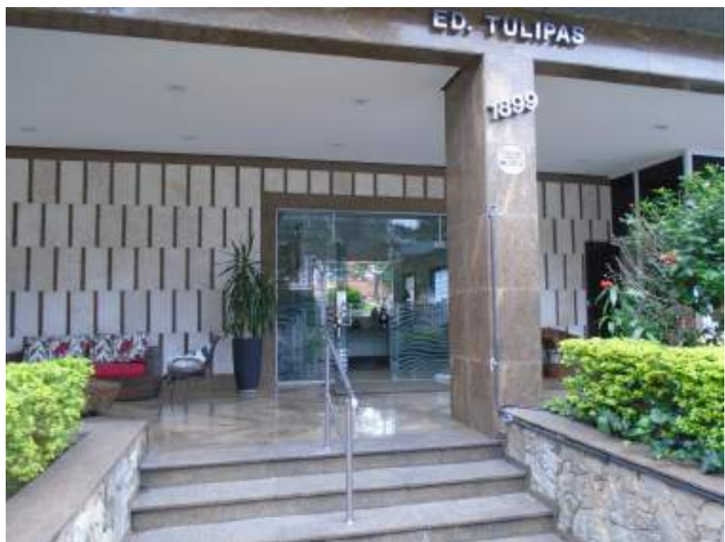
Foto nº. 17 – Vista da entrada do hall social.
