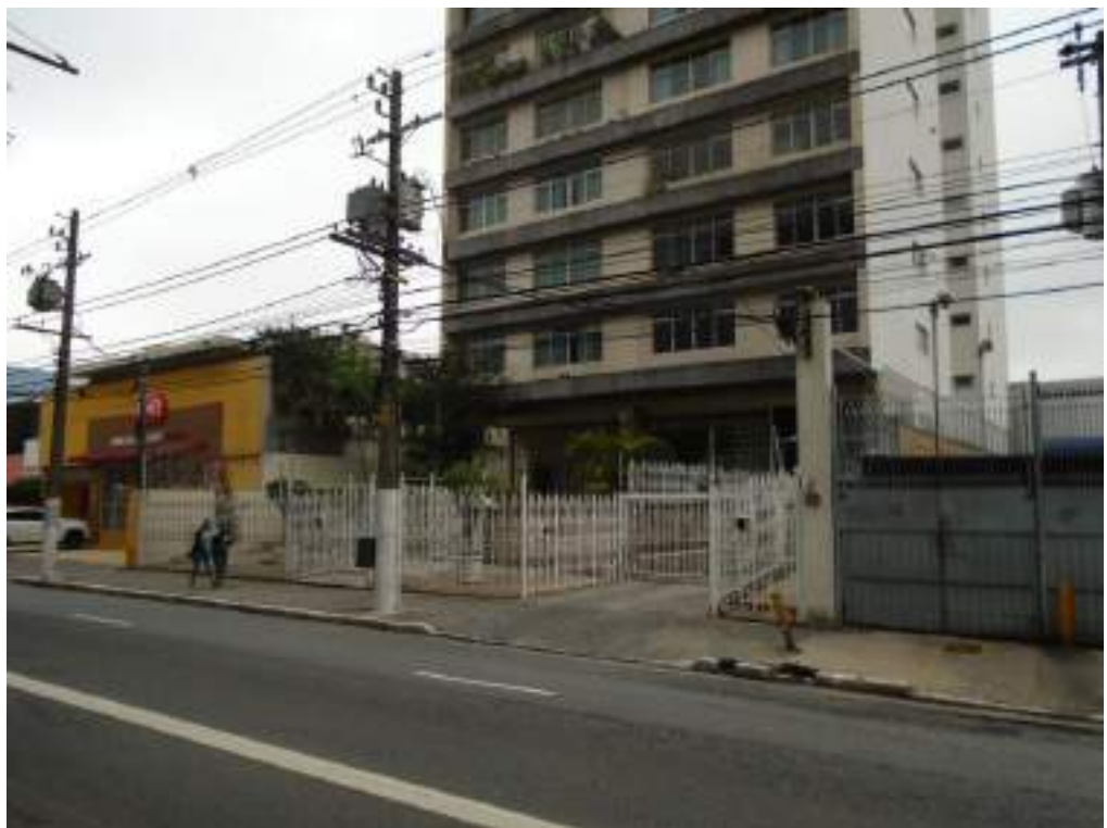
Foto nº. 4 – Vista da entrada do Condomínio Edifício Tulipas.
