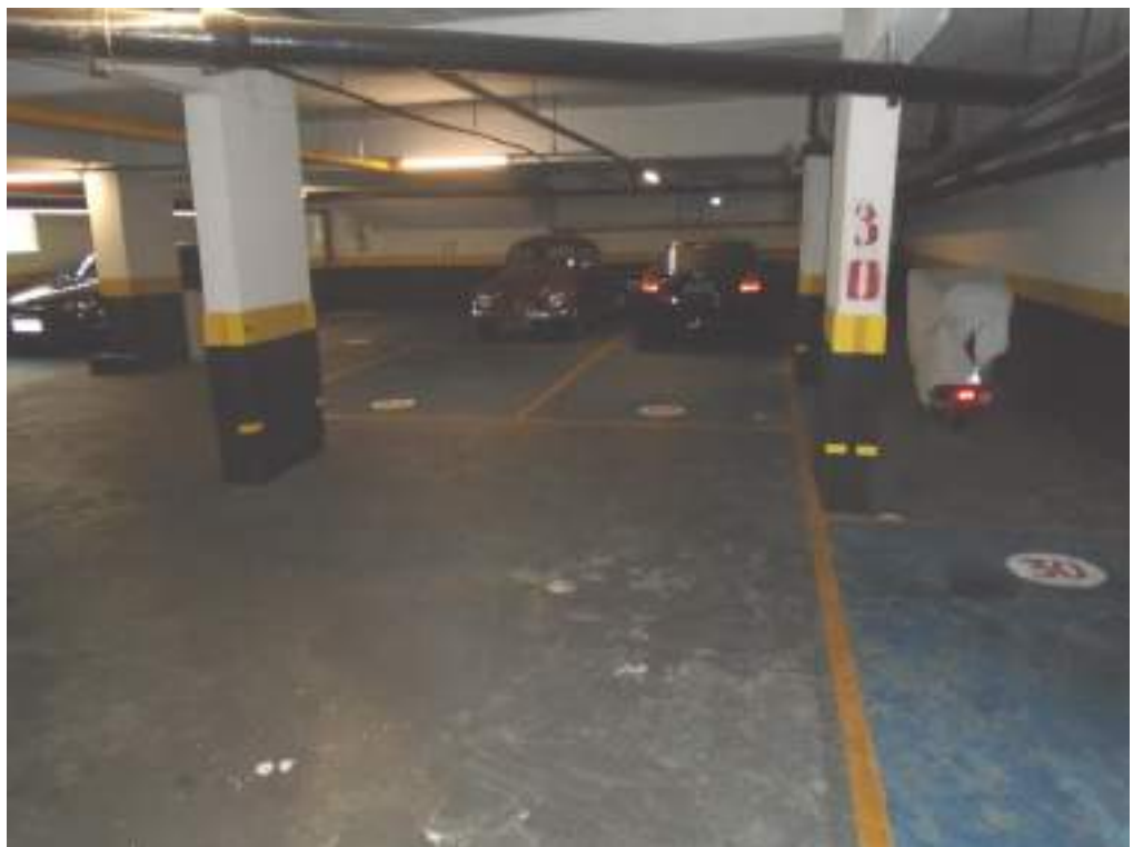
Foto nº. 15 – Vista parcial do subsolo.
