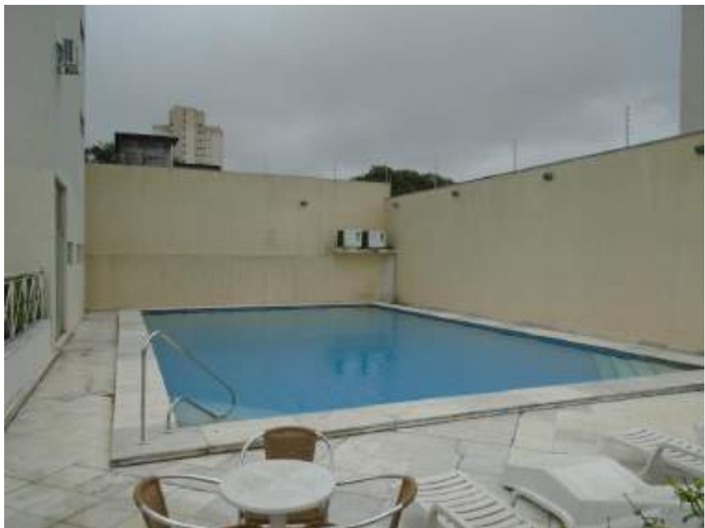
Foto nº. 5 – Vista da piscina.
