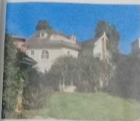
Vista da fachada lateral
