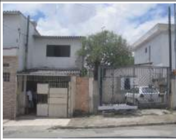
Vista geral do imóvel avaliando (edificações residenciais nº 467 e 469)
