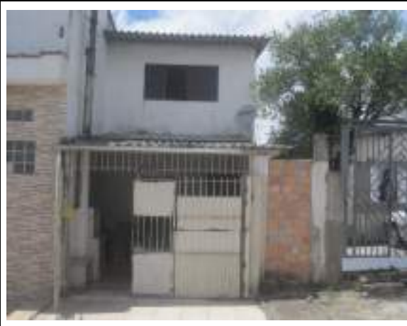
Vista da edificação residencial sob nº 467
