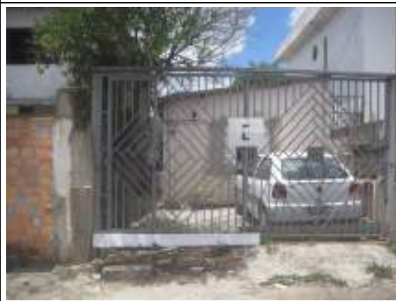
Vista da edificação residencial sob nº 469
