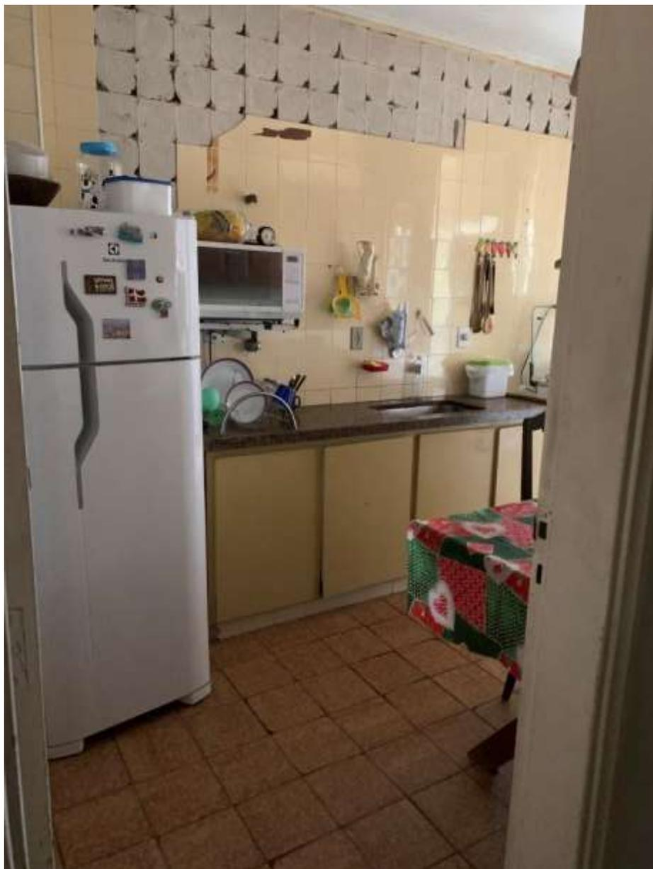
*Foto 22 – Vista de parte da cozinha em direção à área de serviço; pode-se visualizar o destacamento de parte do revestimento de azulejos da parede, requerendo reposição ou substituição total.*
