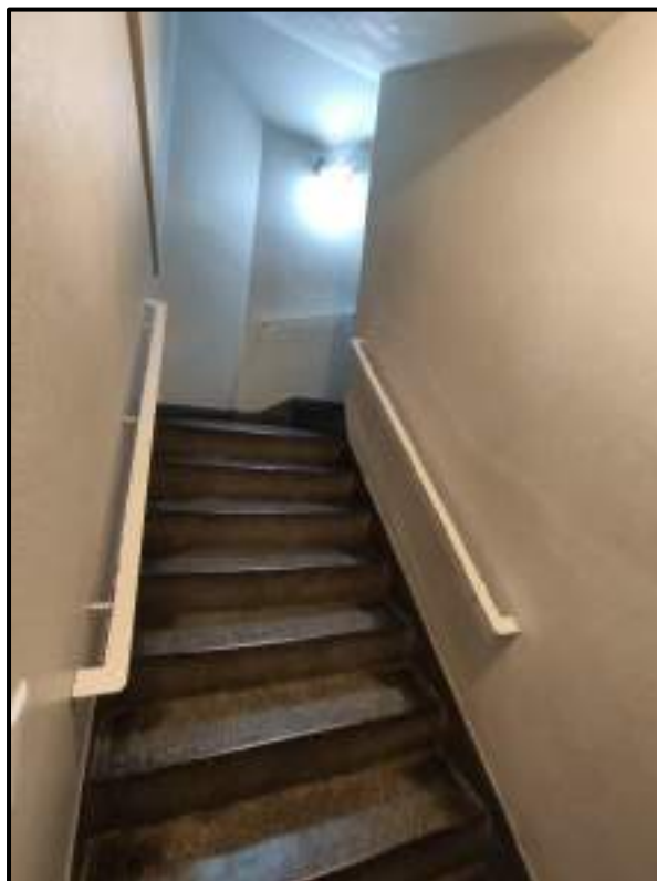
Foto 6: Área Comum – Vista das escadas de acesso aos apartamentos
