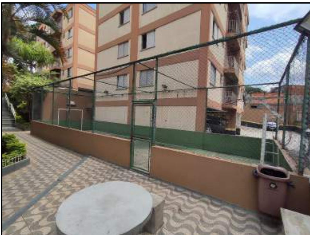
Foto 14: Área Comum – Vista da quadra poliesportiva
