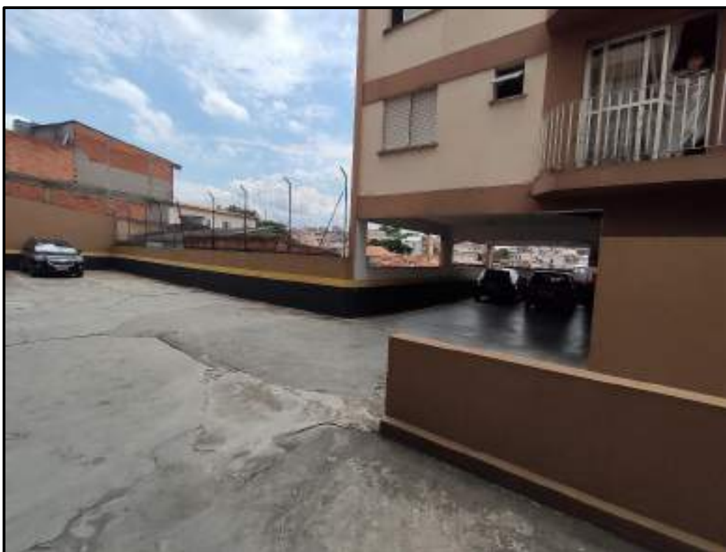
Foto 7: Área Comum – Vista do estacionamento coberto e descoberto do empreendimento
