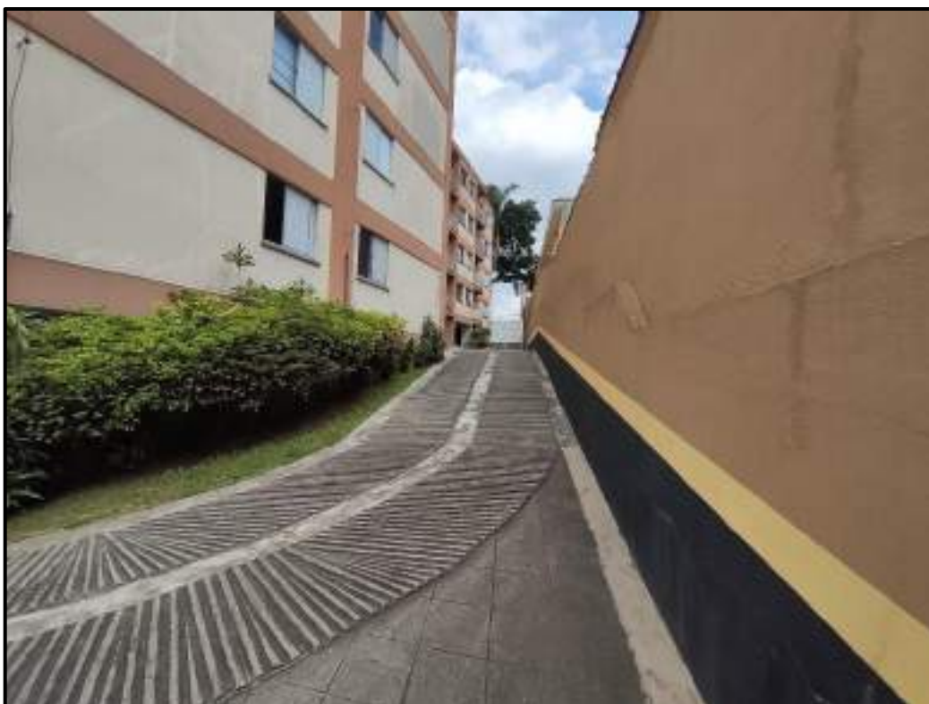
Foto 9: Área Comum – Vista do corredor de circulação de veículos
