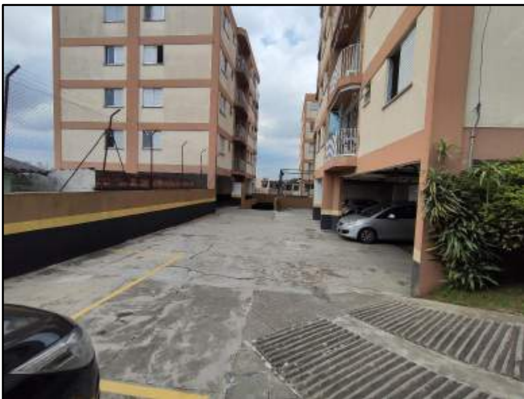
Foto 10: Área Comum – Vista do estacionamento do empreendimento
