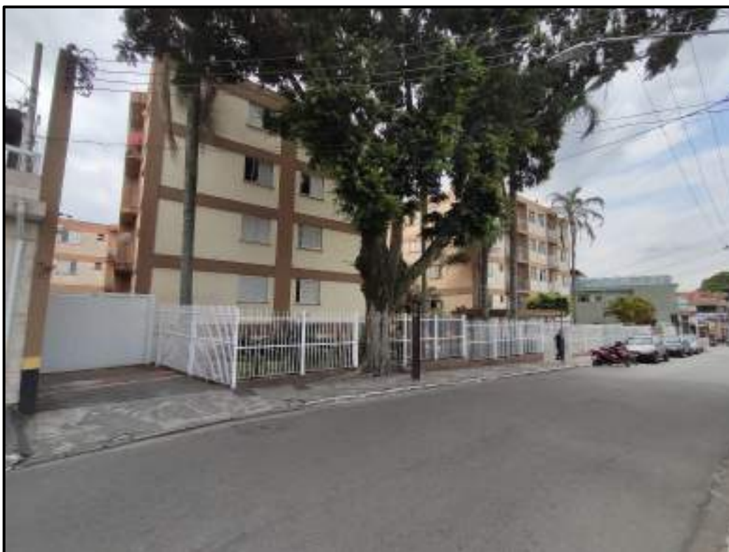
Foto 2: Fachada do Residencial Saint Louis, Rua Luiz Grassmann, 774, São Paulo – SP
