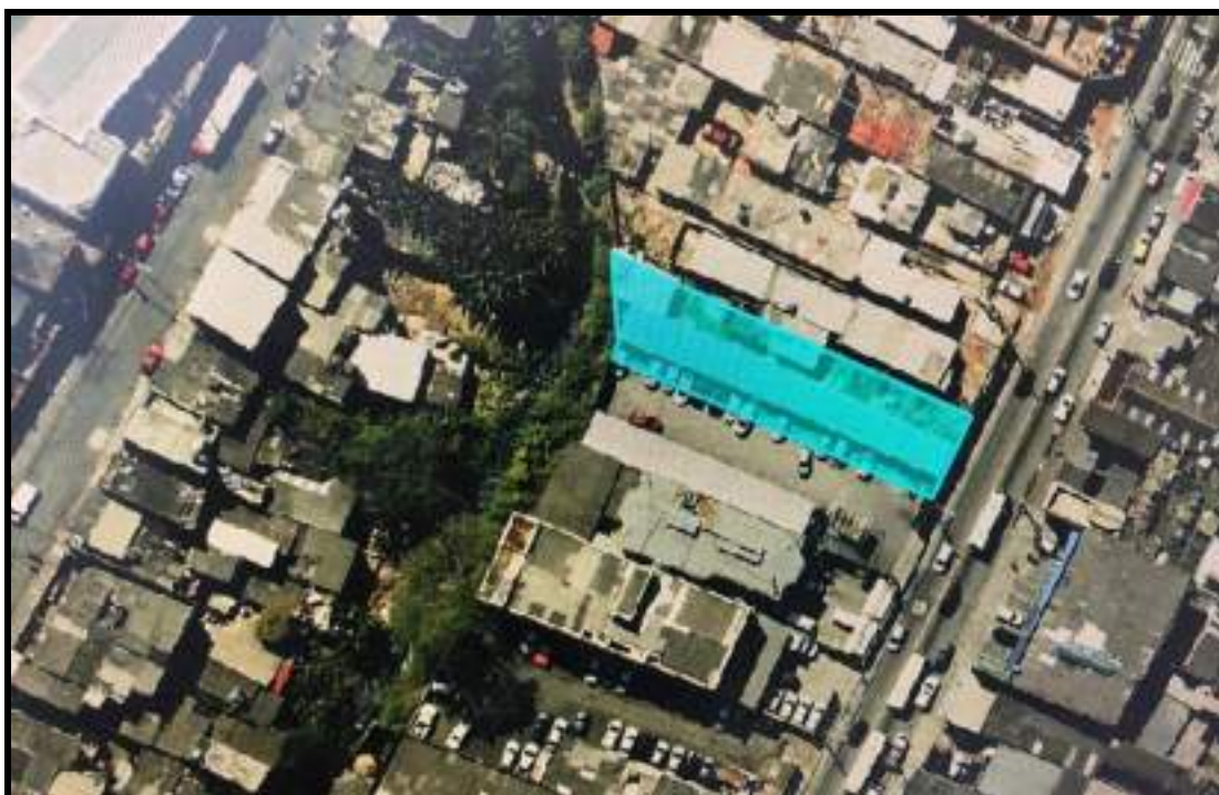
Figura 8: Vista aérea do imóvel
