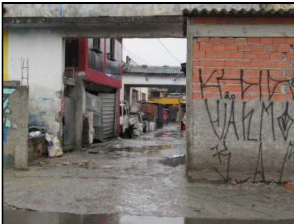
Foto 6: Rua Harry Dannenberg, nº 106 e 148 - Vestígio de invasão
