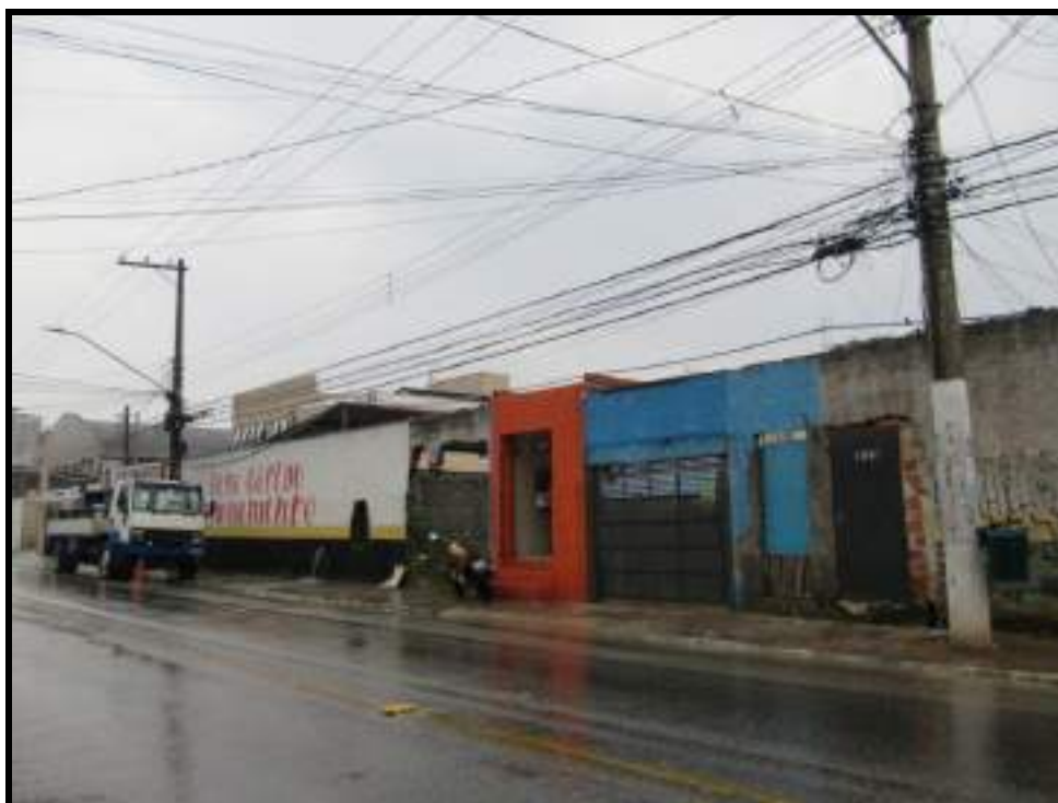
Foto 8: Rua Harry Dannenberg, nº 256
