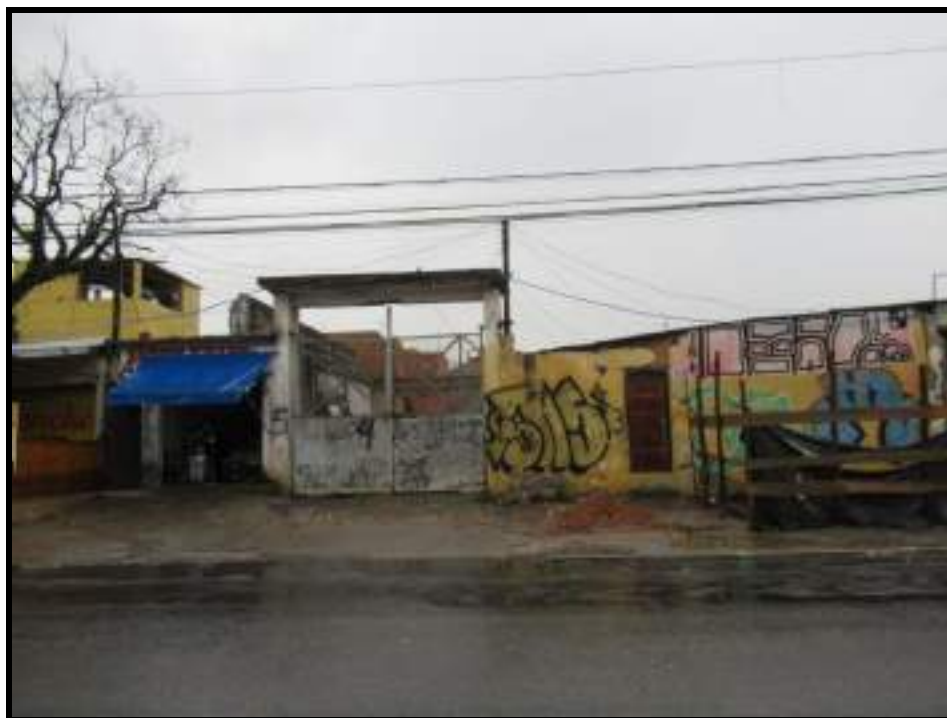
Foto 8: Rua Harry Dannenberg, nº 106 e 148 - Vestígio de invasão
