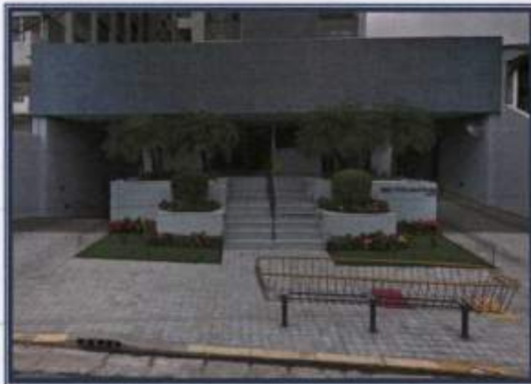
Vista da entrada principal do Condomínio do Edifício Tocantins.
