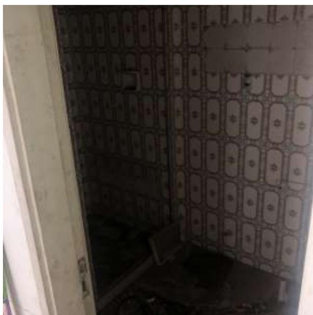
**FOTO 11 – VISTA DE UM DOS BANHEIROS, COM QUEDA DE AZULEJOS E AUSÊNCIA DE INSTALAÇÕES HIDRAULICO SANITÁRIAS**
