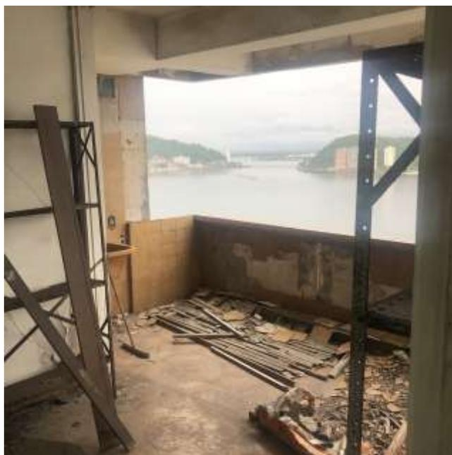
**FOTO 12 – VISTA DA ÁREA DE SERVIÇO COM DEPENDENCIA CONJUGADA, SEM ESQUADRIAS ENTRE OS AMBIENTES BEM COMO JUNTO A FACHADA EXTERNA, QUEDA DE PLACAS CERÂMICAS E PISO DETERIORADO, ALEM DE TRINCAS NAS PAREDES**
