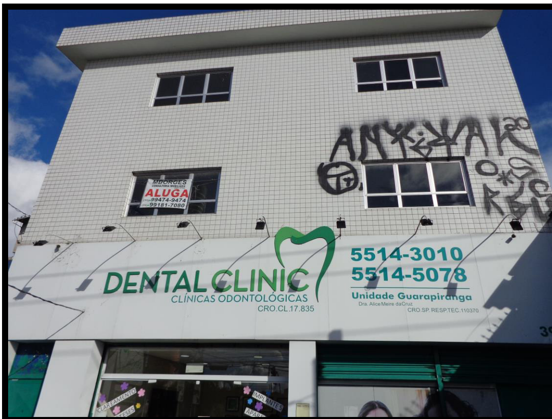
Vista frontal do imóvel avaliando.
