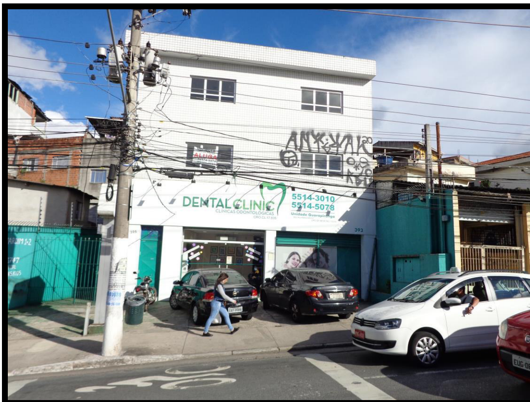
Outra vista frontal do imóvel avaliando.
