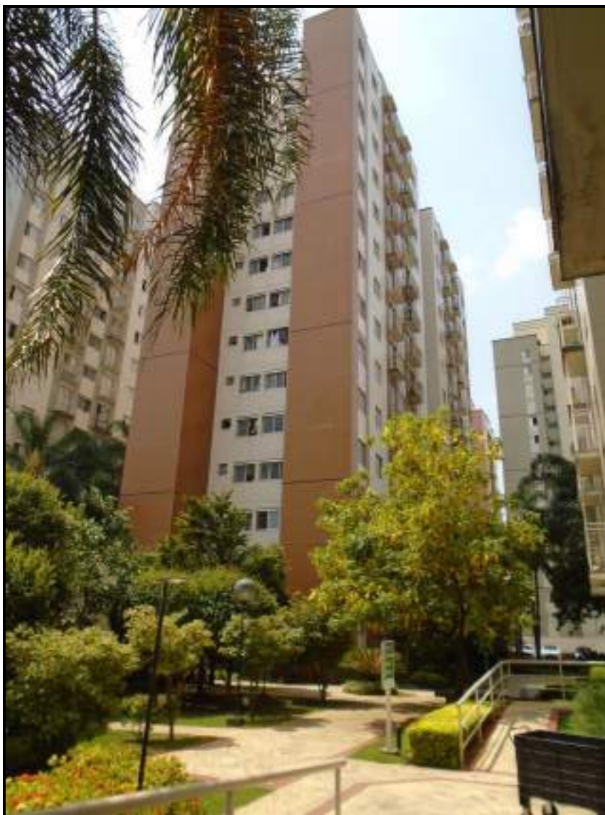
ASPECTO GERAL DO BOM ESTADO DE CONSERVAÇÃO.
