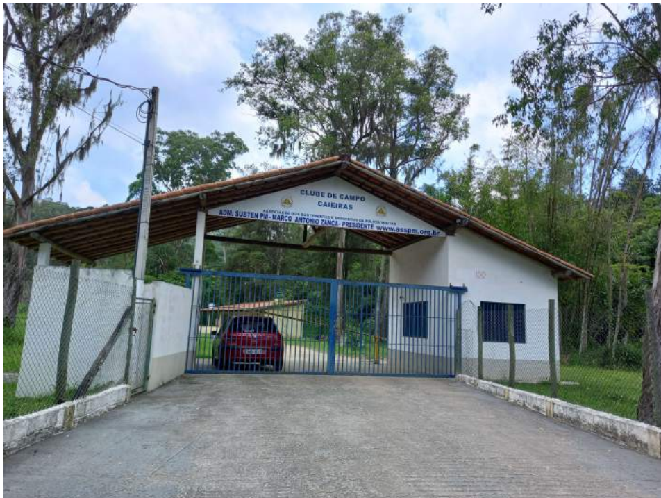
Acesso – Entrada Principal
