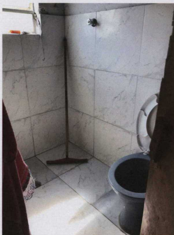
Foto 4- WC existente ao lado do comodo da foto anterior.
