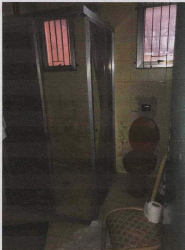
Foto 12- Banheiro do imóvel.
