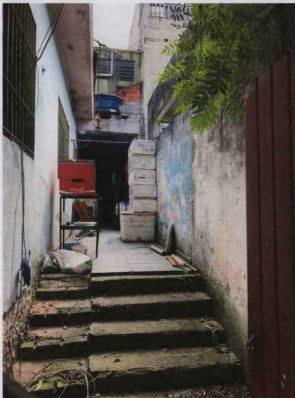
Foto 5- Recuo lateral e acesso à parte dos fundos da edificação.
