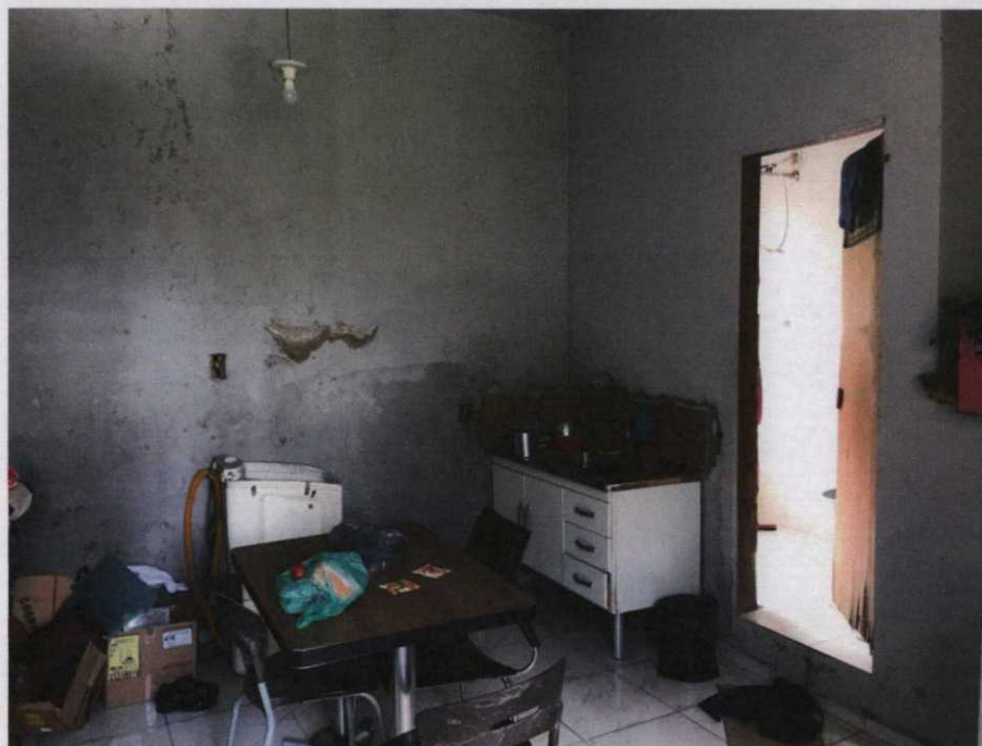
Foto 3- Comodo existente sobre a garagem
