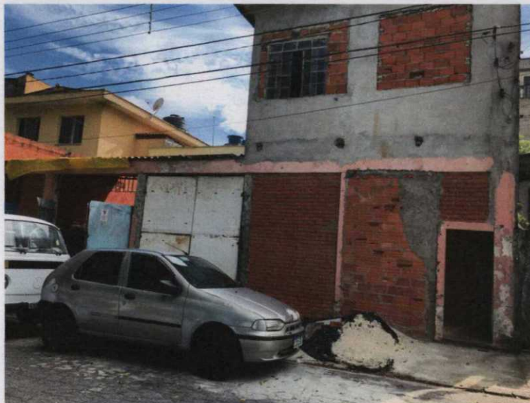
Foto 1- Frente da edificação vistoriada.
