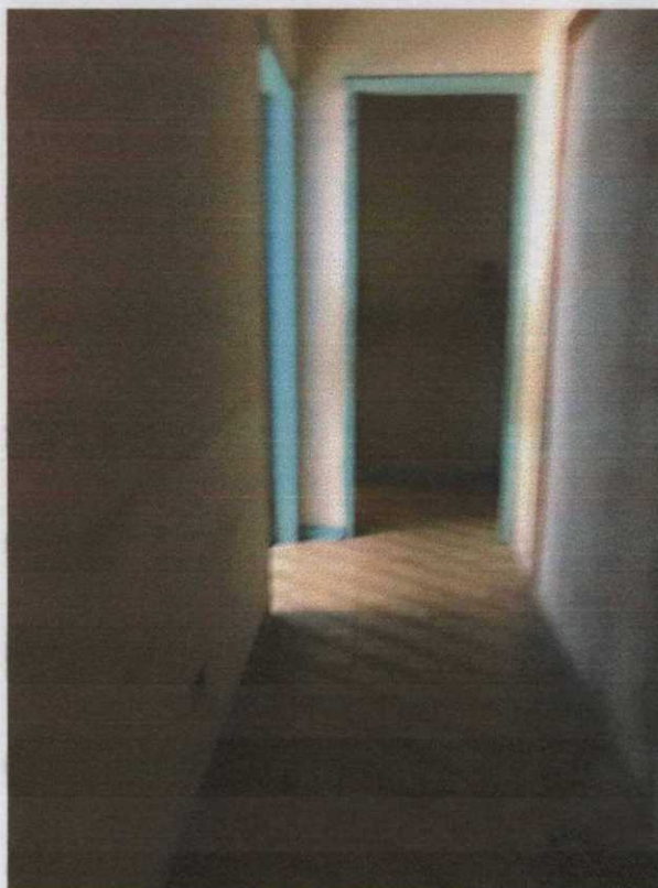
Foto 8- Acesso aos dormitórios.
