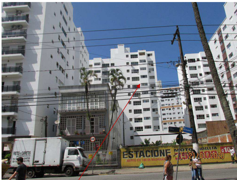
Foto 2 - Vista do Edifício Liverpool, onde se localiza a unidade penhorada; o prédio fica recuado em relação a entrada do condomínio
