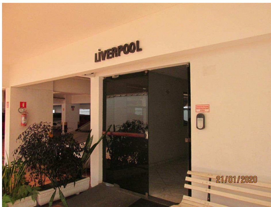
Foto 6 - Entrada para o hall social do Edifício LIVERPOOL, onde se localiza a unidade avalianda
