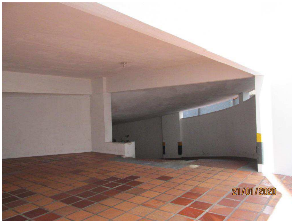
Foto 12 - Rampa de acesso para a garagem no térreo/subsolo
