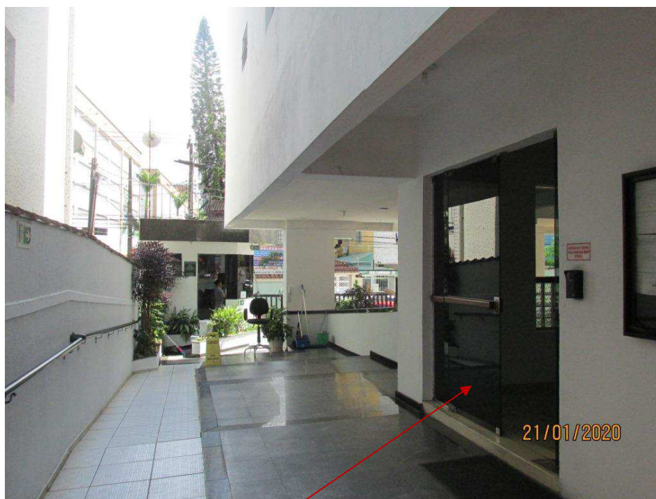
Foto 4 - Corredor de acesso a todos os condôminos; entrada para o hall social do Edifício OXFORD
