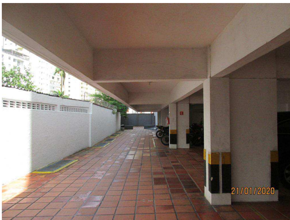
Foto 7 - Vista parcial do térreo – acesso e garagens, sob o Edifício LIVERPOOL
