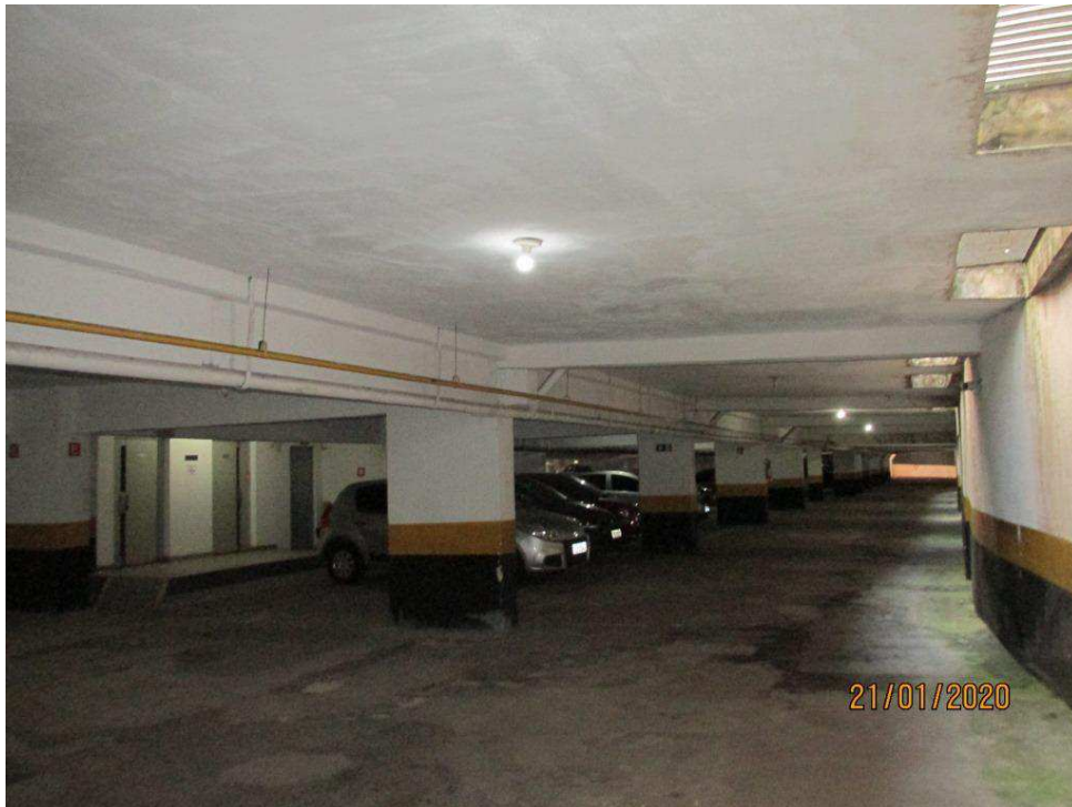
Foto 10 - Vista parcial das vagas de garagem no subsolo
