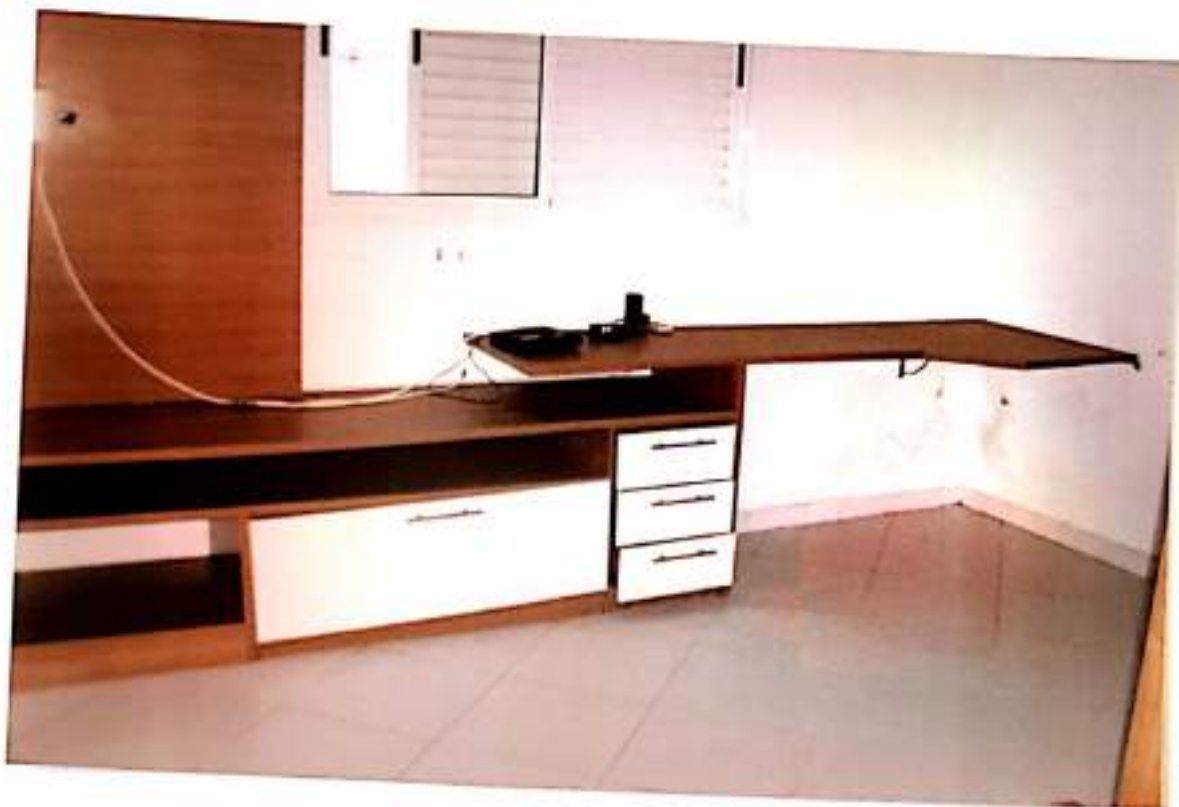
foto 24 – suíte máster com piso de porcelanato, paredes com massa corrida e látex.
