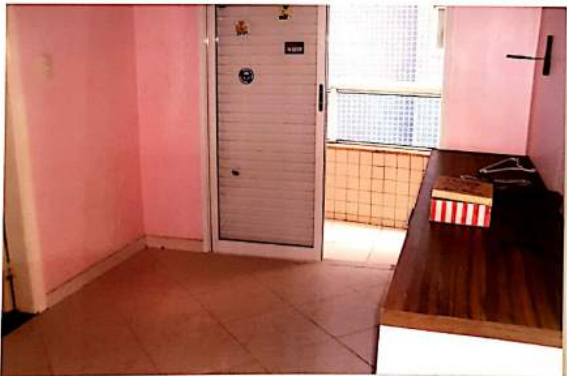
foto 28 – suíte intermediária com piso de porcelanato, paredes com massa corrida e látex, portal de acesso à sacada de alumínio anodizado..
