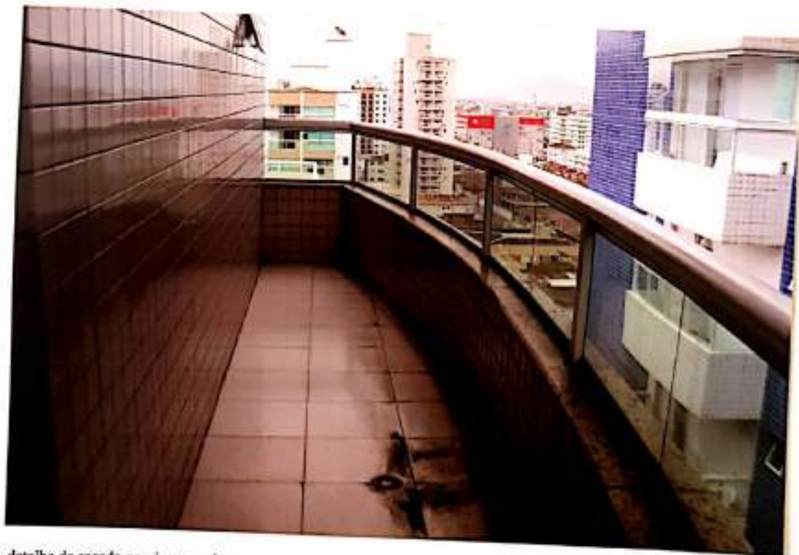
Foto nº 23- detalhe da sacada no piso superior
