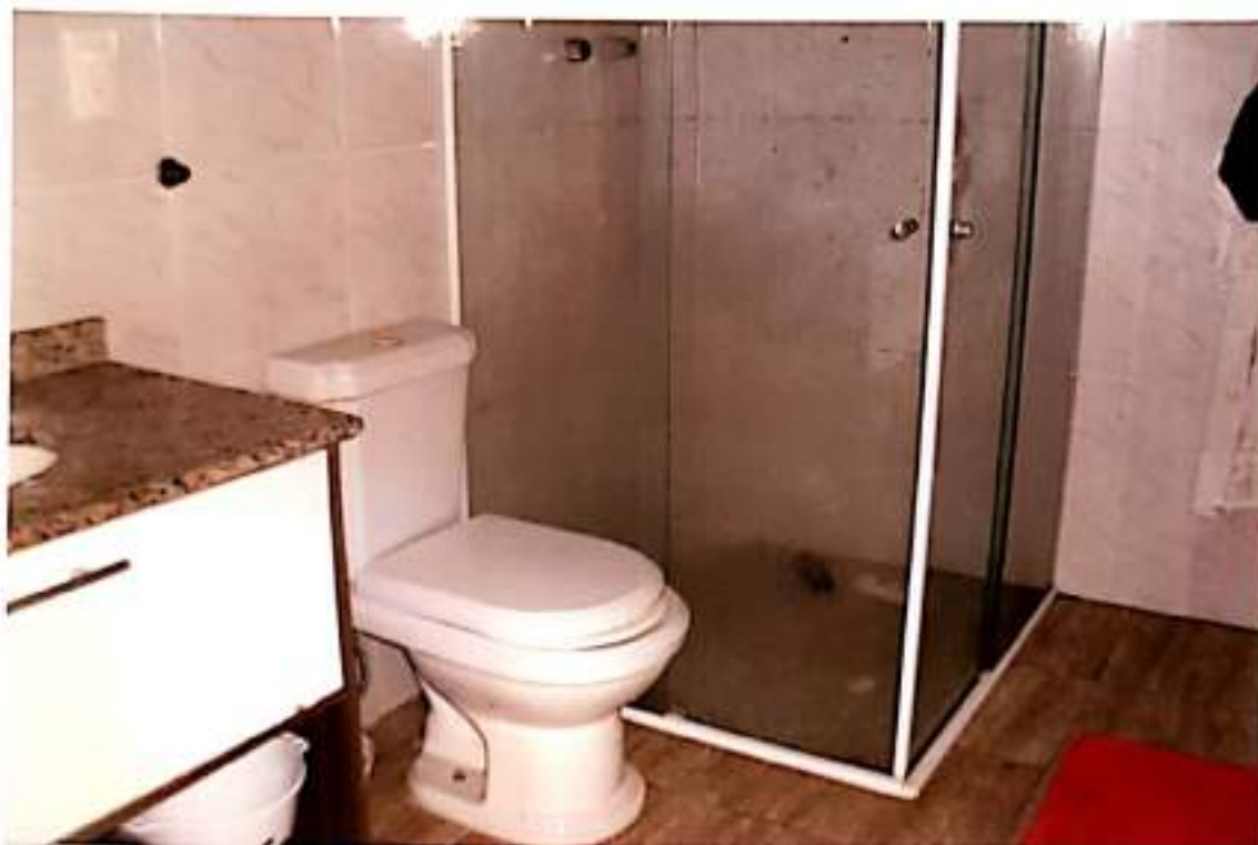
foto nº 29 - banheiro da suite intermediária com piso e paredes de porcelanato, box blindex e louça sanitária de boa qualidade
