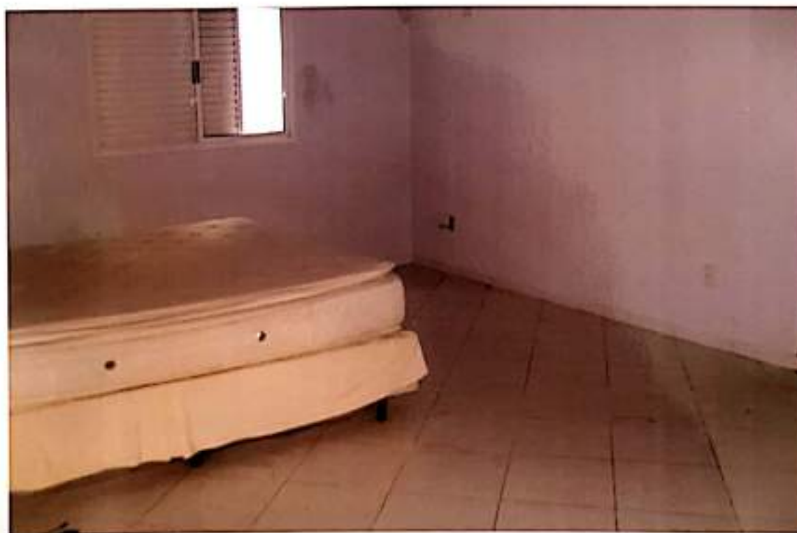
foto 30 – terceira suite com piso de porcelanato, paredes com massa corrida e látex.
