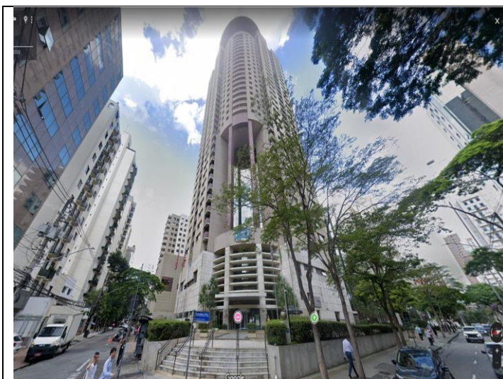
Fachada do Edifício STAYBRIDGE SUITES CENTURY PLAZA Apartamento 2606, localizado no 26º pavimento – BLOCO A Condomínio Brascan Century Plaza. Endereço: Esquina Rua Bandeira Paulista com Rua Professor Tamandaré Toledo.
