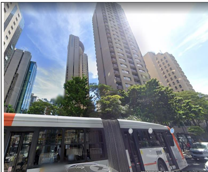
Logradouro. Rua Joaquim Floriano, 466. Fachada do Edifício STAYBRIDGE SUITES CENTURY PLAZA Apartamento 2606, localizado no 26º pavimento – BLOCO A Condomínio Brascan Century Plaza.
