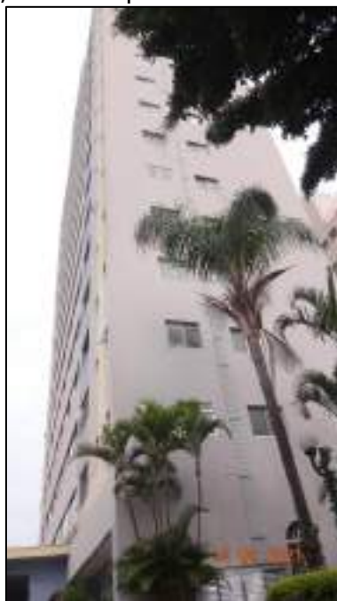
FOTO 03: Vista da Fachada do Edifício "Veneza" , onde está a unidade avalianda, tomada pela Rua dos Campineiros.
