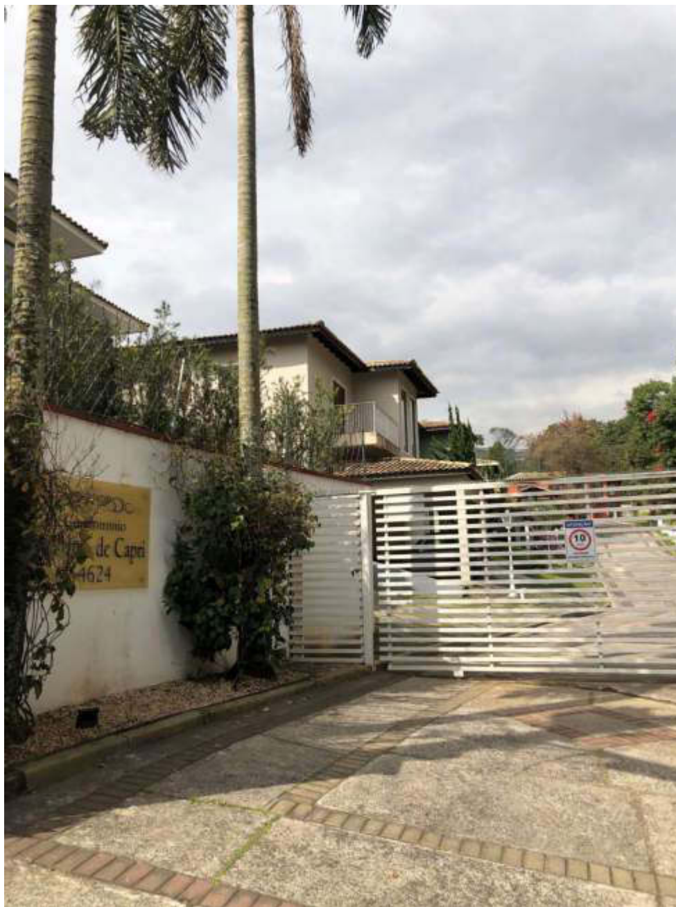
Figura 4: Estrada da Fazendinha 4.624 – Condomínio Villagio de Capri – vista das residências
