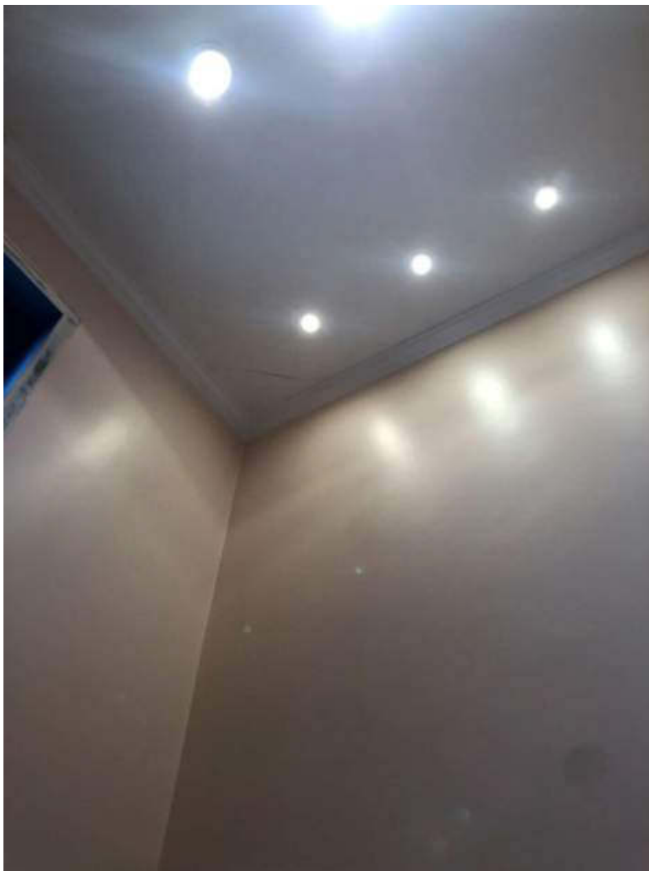
Figura 27: marcas aparentes de fissuras no teto do lavabo
