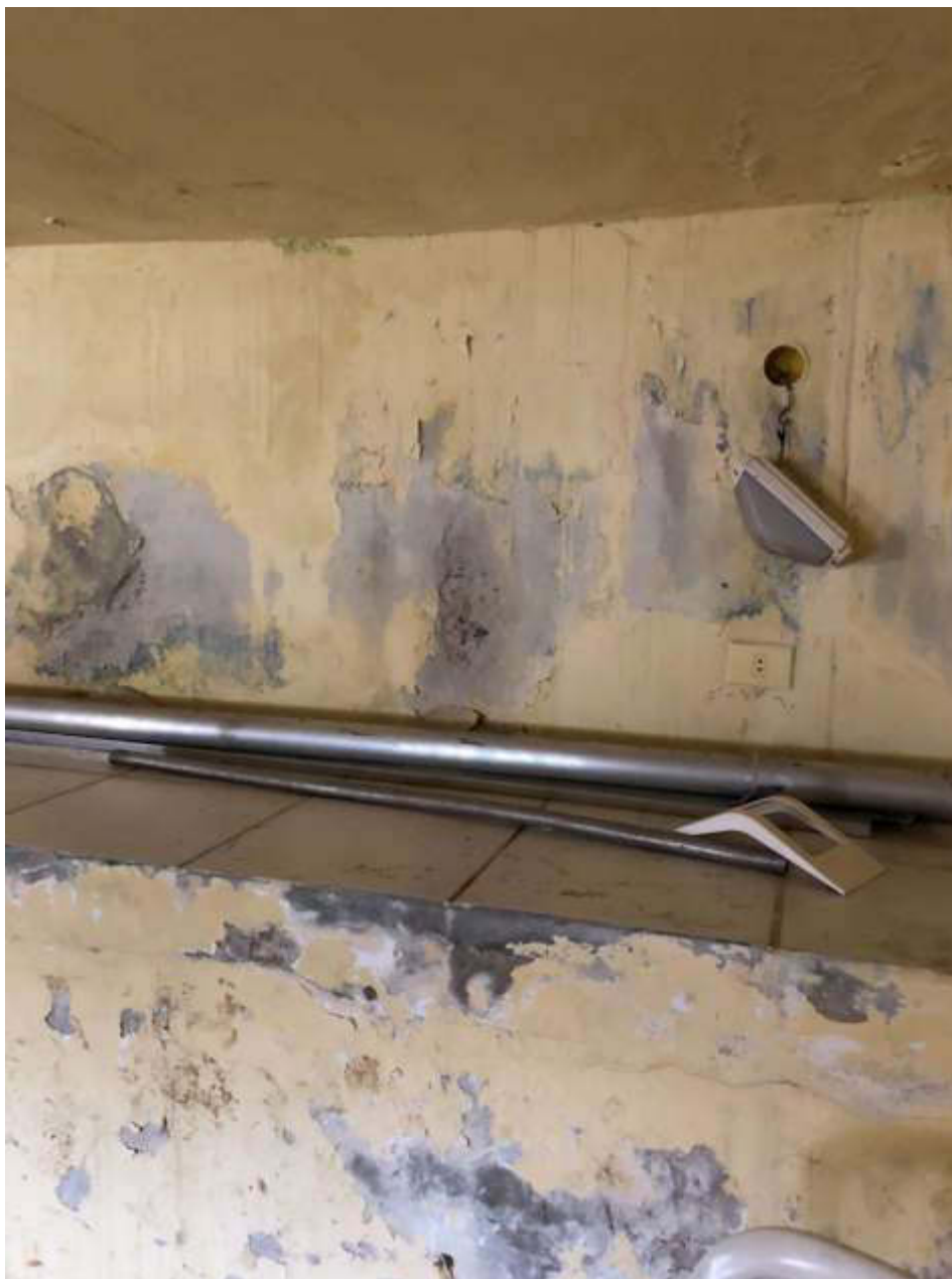
Figura 75: depósito - subsolo - piscina
