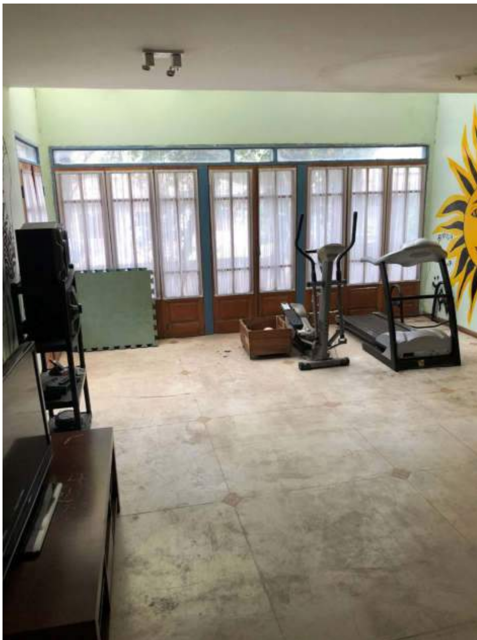
Figura 117: sala de ginástica – marcas de infiltração no teto
