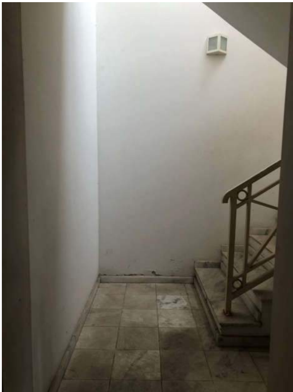
Figura 88: escada de acesso às suítes 3 e 4
