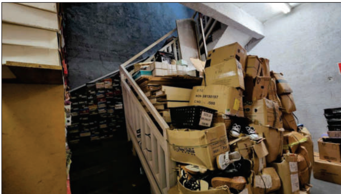
Figura 14: Escada de acesso ao 2º Pavimento
