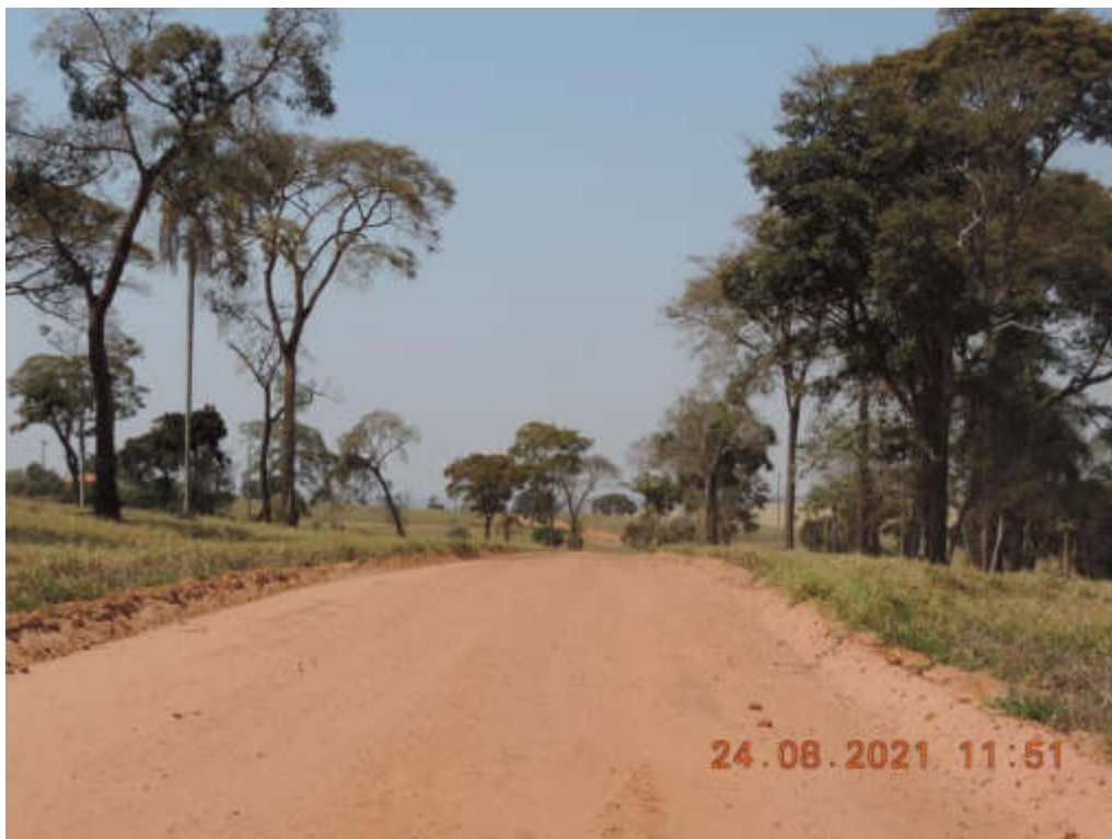
Foto 05 - Rua 161 sem pavimentação
