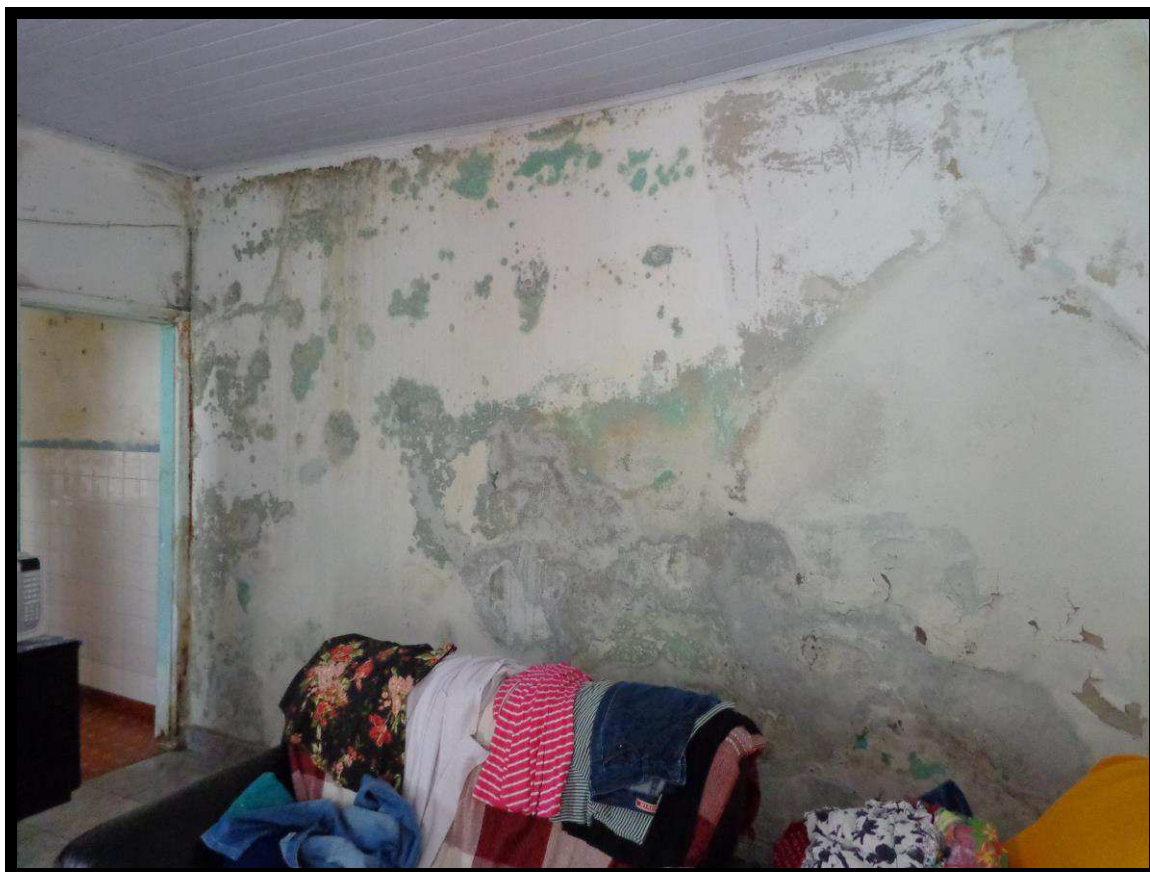
Vista da sala do imóvel avaliando.
