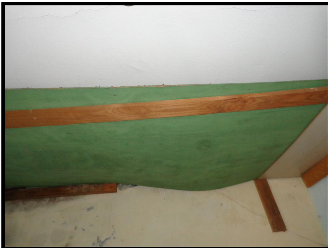
Detalhe do teto do segundo dormitório do imóvel avaliando.
