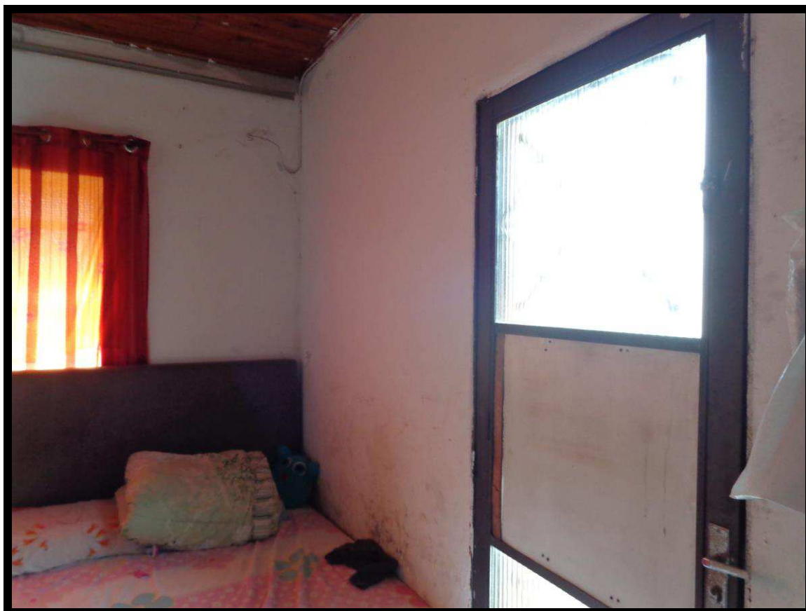
Detalhe do estado da construção do imóvel avaliando.
