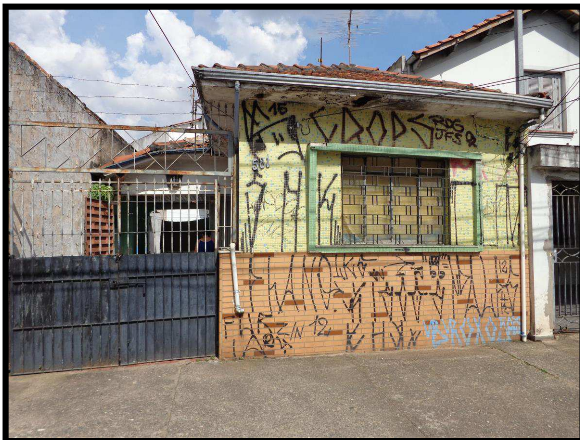
Vista da fachada do imóvel avaliando.
