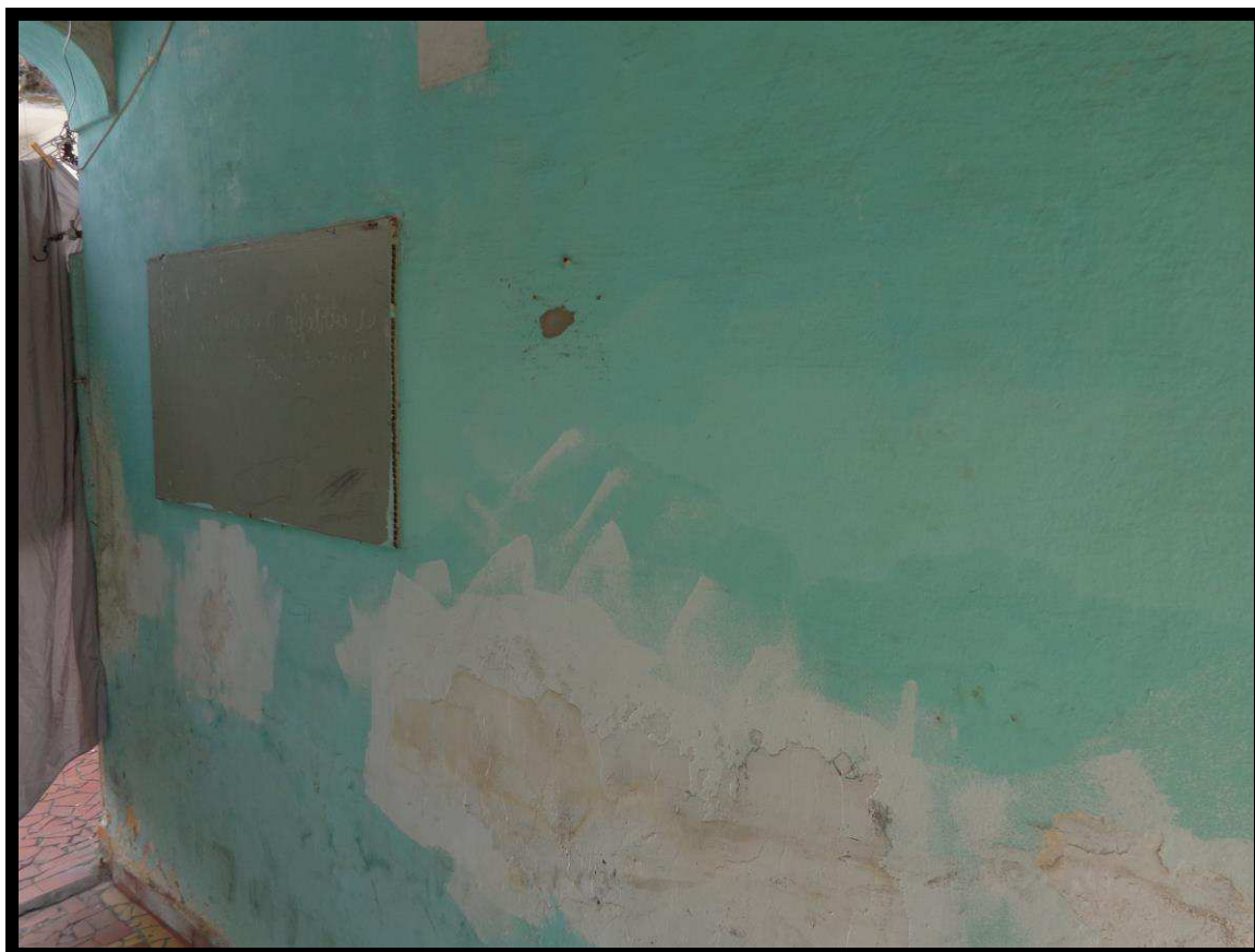
Detalhe da construção do imóvel avaliando.
