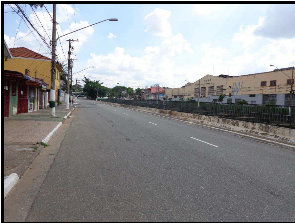
Vista da Avenida Teresa Cristina.
