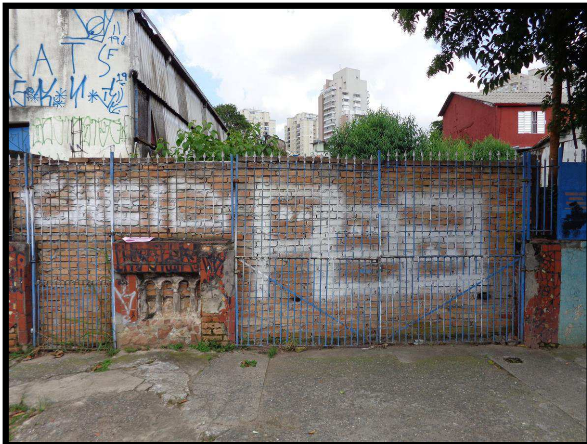
Outra vista da fachada do imóvel avaliando.
