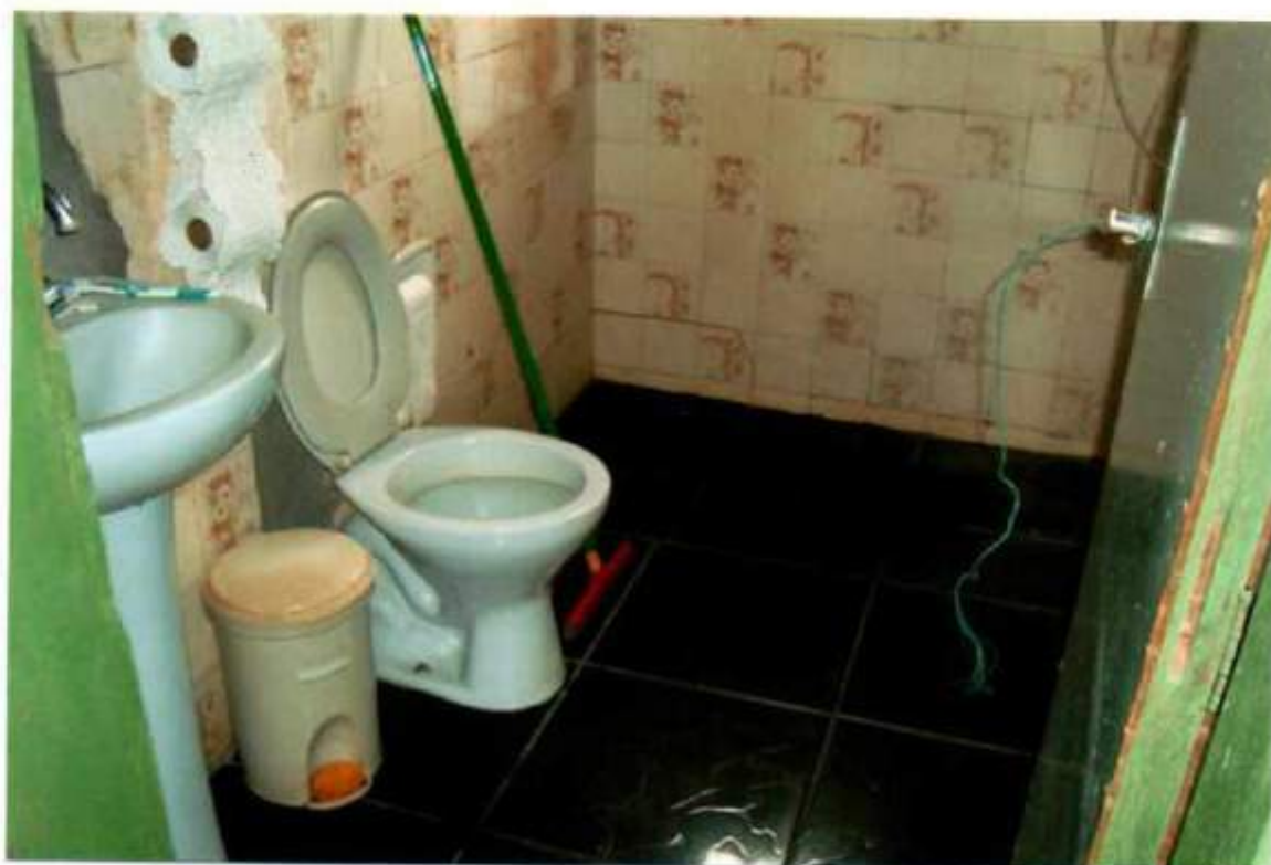
Vista parcial do interior do único sanitário e banho.
