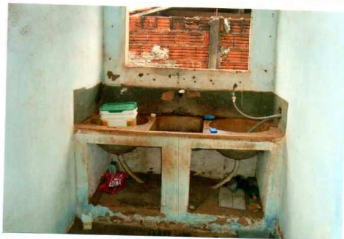
Vista parcial do interior da cozinha e área de serviço na parte dos fundos da construção.
