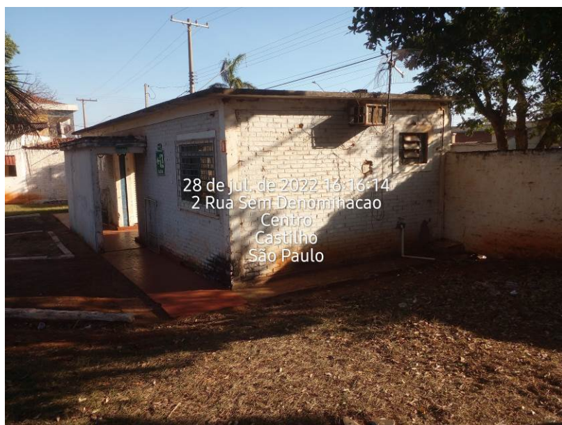
Foto 3: : Idem, edificação 1: Portal de acesso ao clube
