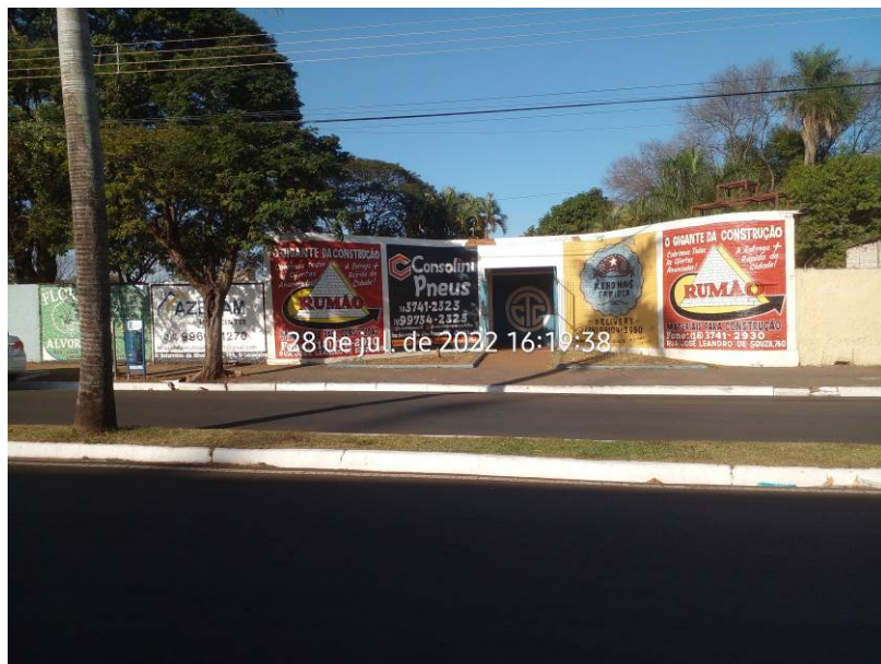
Foto 2: : Edificação 1: Portal de acesso ao clube (Área = 24,60m 2 ), 01 unidade Descrição: Edificação em alvenaria de tijolos comuns, revestida, com dimensão de 10,00m x 2,00m mais 4,00m x 1,15m (Área construída pé direito 2,85m, piso cimentado, forro laje de concreto, com instalações elétricas e hidráulicas. Estado de conservação: REGULAR
