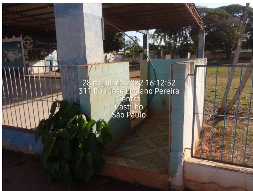
Foto 10: Box-chuveiro (4,92m2/unidade), 02 unidades
