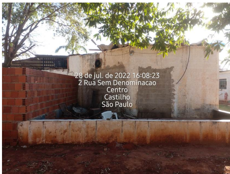
Foto 6: Idem, edificação 3: Lanchonete (Área = 83,86m 2 )
