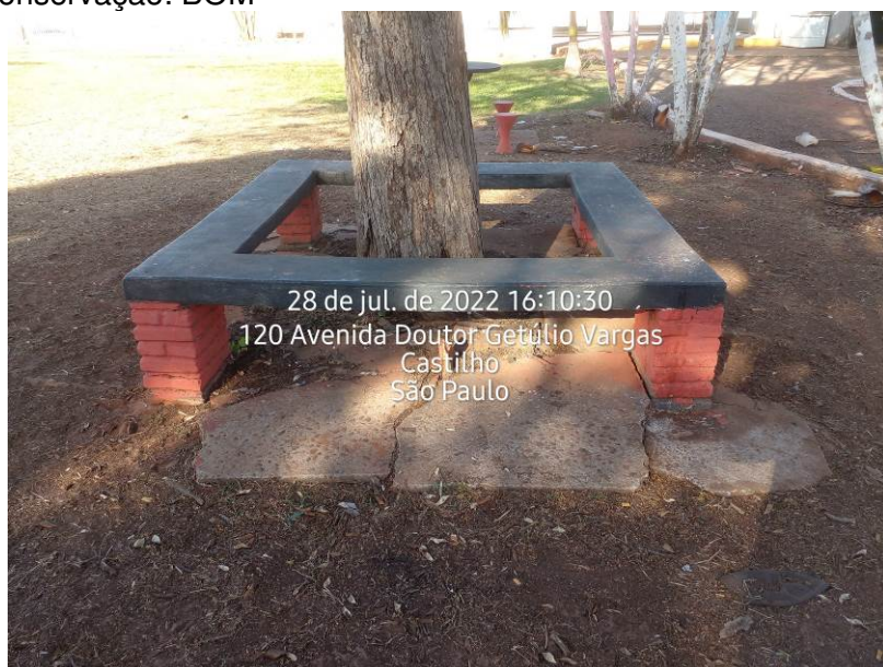
Foto 13: Banco de concreto apoiado em alvenaria de tijolos comuns e base de concreto (1 unidade)
