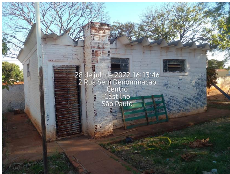
Foto 4: : Edificação 2: Edificação de apoio (Área = 49,73m 2 ), 1 unidade
