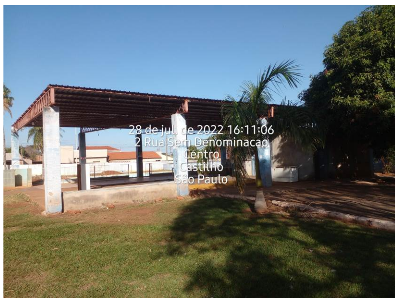
Foto 7: Edificação 4: Galpão aberto (Área = 330,00m 2 ), 01 unidade
