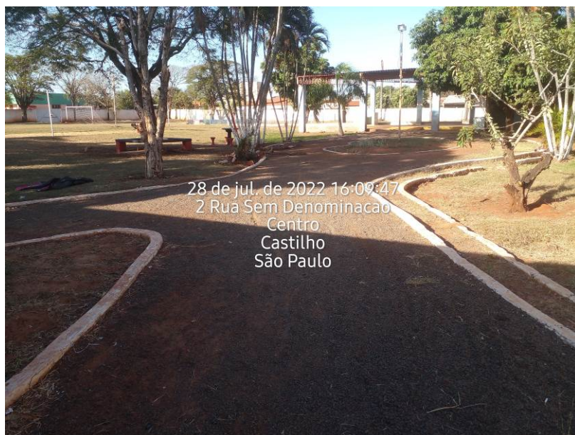
Foto 15: Passeio de alvenaria de tijolos comuns revestidos (Qde. Estimada 250,00m)
