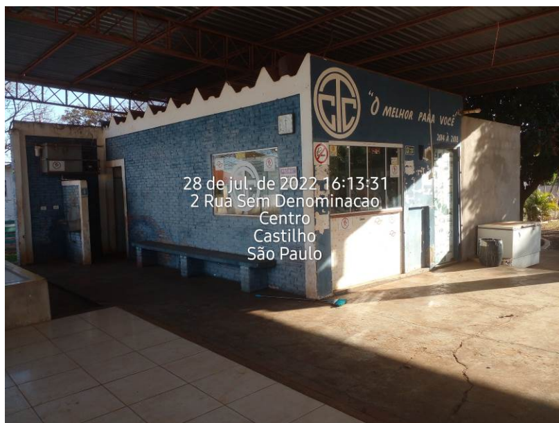
Foto 8: Edificação 5: Sala de Administração, dotada de sanitários públicos masculino e feminino (Área =42,16m 2 ), 01 unidade
