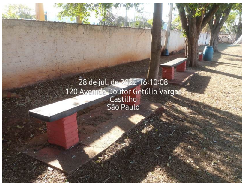
Foto 12: Banco de concreto apoiado em alvenaria de tijolos comuns e base de concreto (3 unidades)
