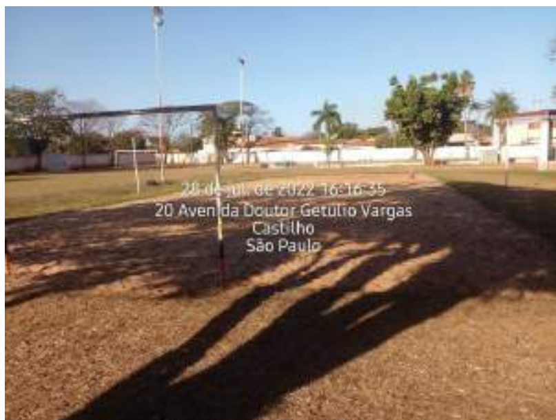
Foto 21: Poste de luz led pétala externo (4 unidades)
