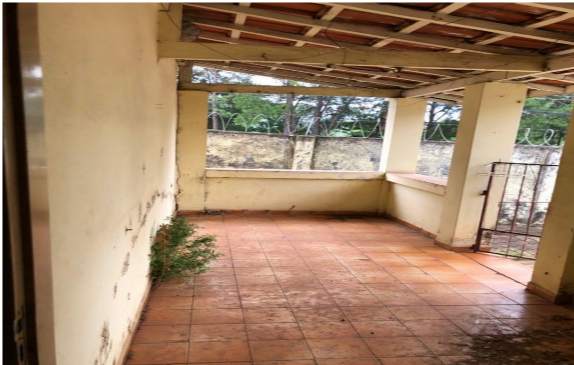
Foto 21 – Parede da área externa que necessita de acabamento e pintura.
