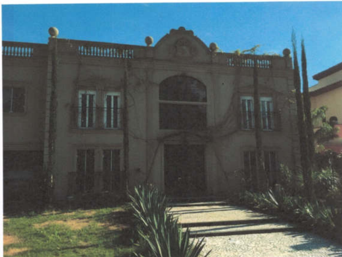
Foto 03 – Vista da fachada de frente para Rua Sucupira.
