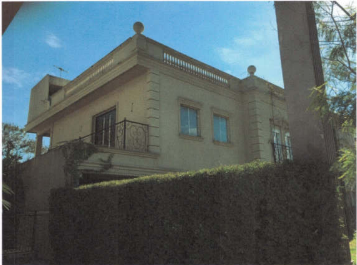
Foto 06 – Vista parcial da fachada lateral direita de quem da rua Sucupira olha para o imóvel.
