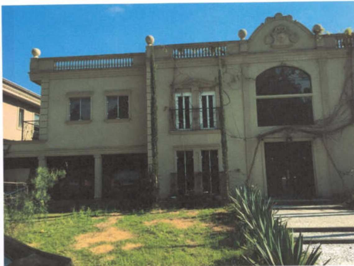
Foto 04 – Vista parcial da fachada de frente para a rua Sucupira, 252.
