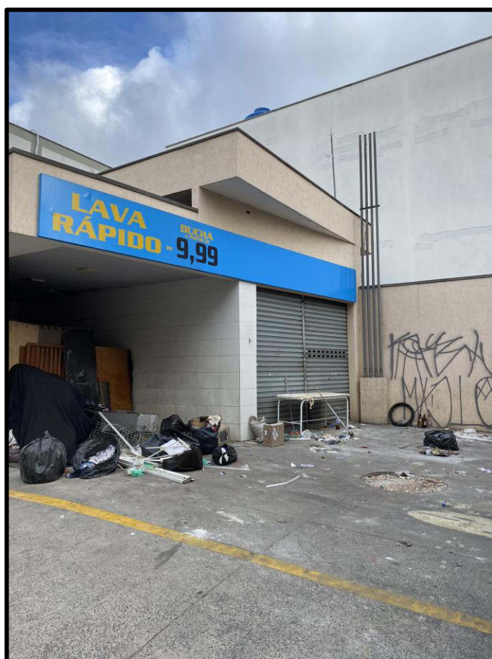
Foto 2: Vista parcial do lava rápido e depósito/troca de óleo
