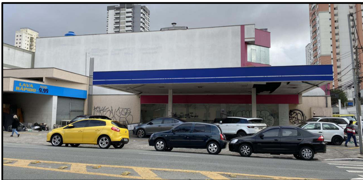
Foto 1: Fachada do Avaliando
