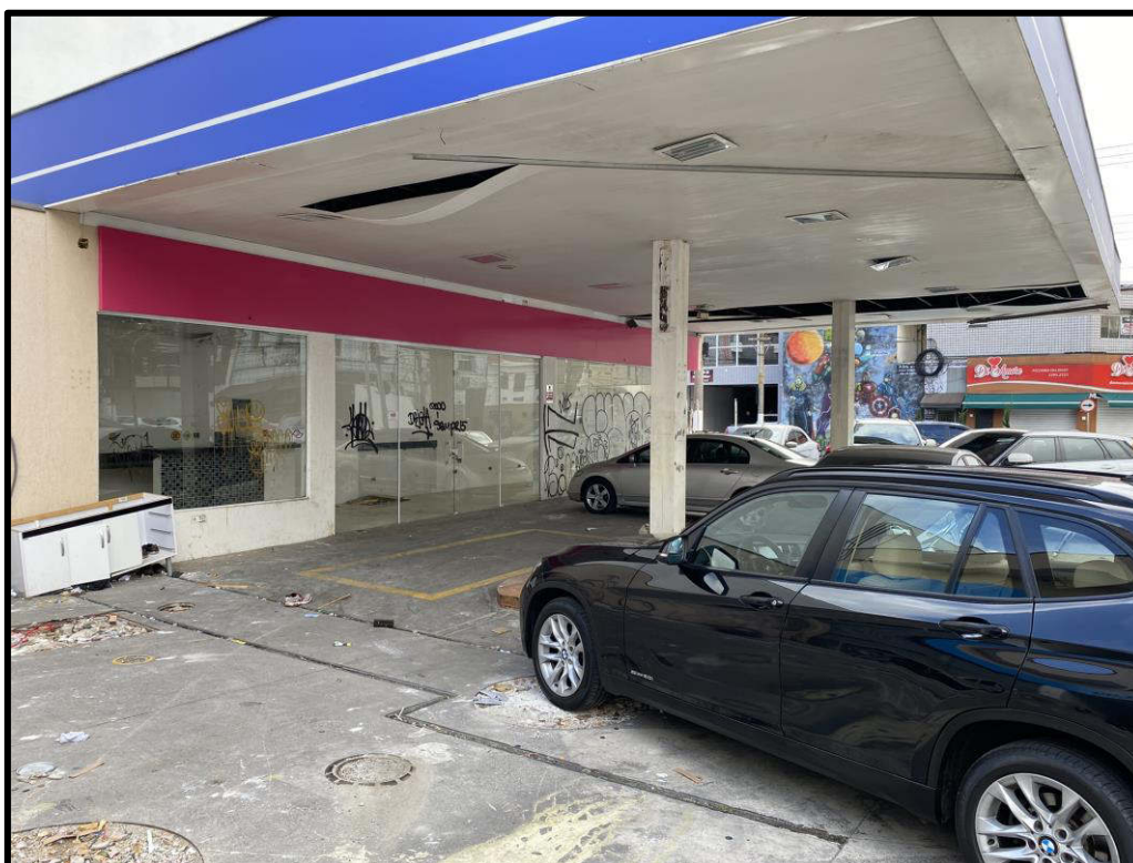
Foto 4: Vista parcial da loja de conveniências e pista principal
